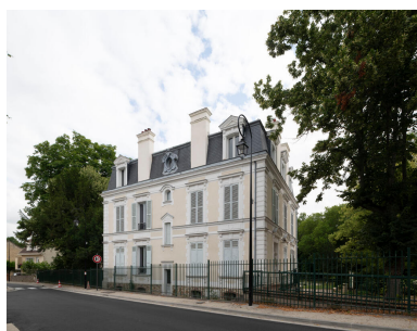
Façade côté rue, orientée sud-ouest. Au centre, l'entrée de service. Repro. Ayrault Philippe, Phot. Ayrault Philippe IVR11_20239500660NUC4A
