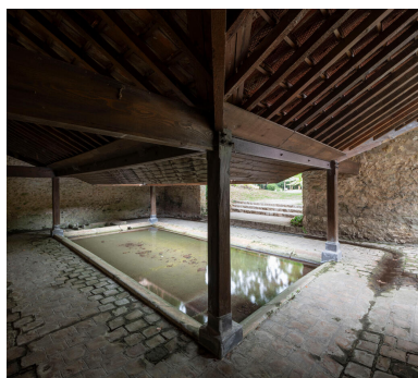
Lavoir à impluvium, qui alimente le grand bassin servant au rinçage du linge. Le plus petit, qu'on aperçoit, est utilisé pour le lavage.
