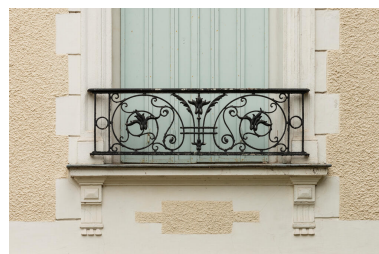
Détail d'un garde-corps du rez-de-chaussée. IVR11_20239500690NUC4A
