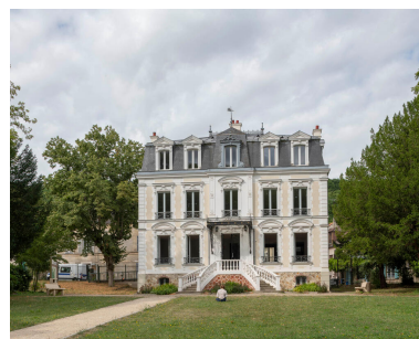
La toiture à la Mansart est surmontée d'une crête de toit et d'épis de faitage. Repro. Ayrault Philippe, Phot. Ayrault Philippe IVR11_20239500656NUC4A
