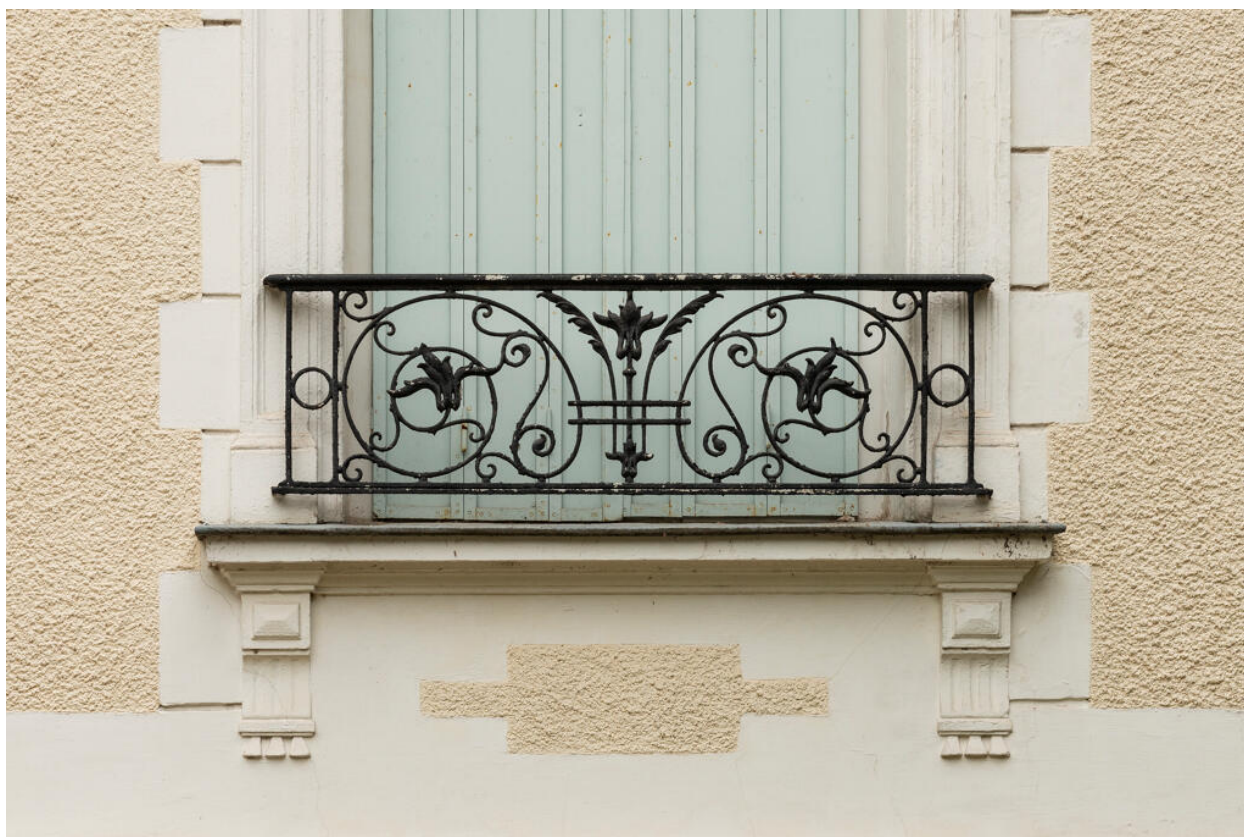
Détail d'un garde-corps du rez-de-chaussée.
