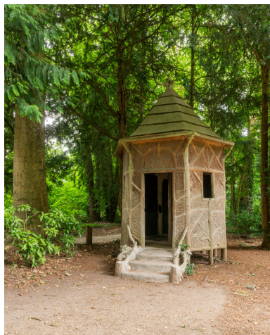
Le kiosque en béton rocaillé. IVR11_20239500692NUC4A
