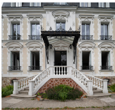
L'entrée principale, côté jardin, et son escalier à montées convergentes, surmonté d'une marquise.
