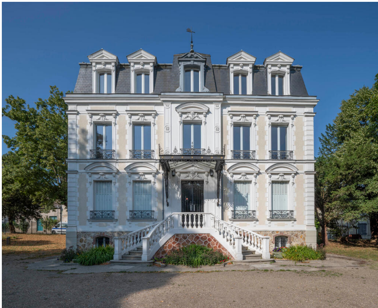
La façade sur jardin, orientée nord-est.
