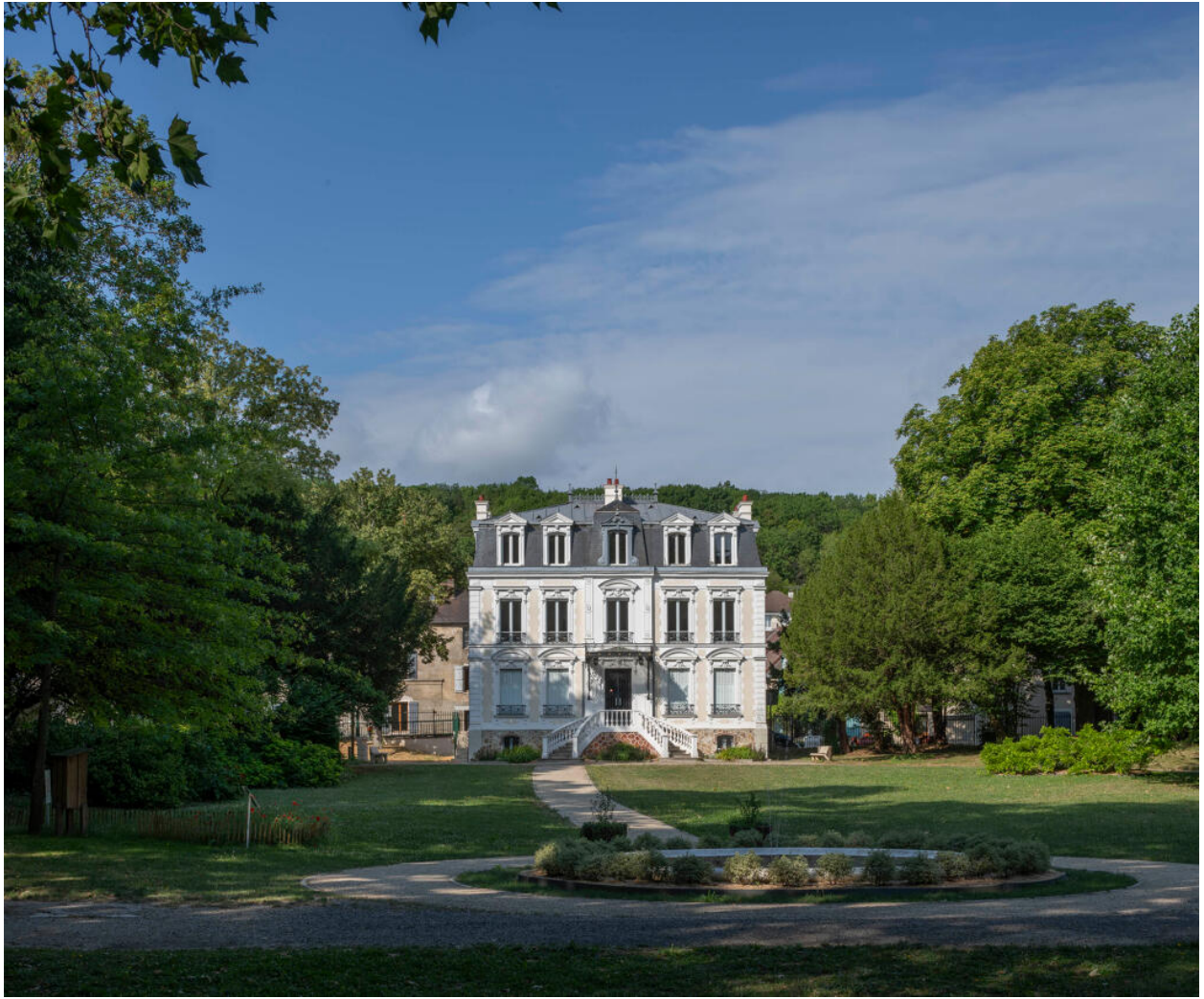
La façade sur jardin, orientée nord-est.
