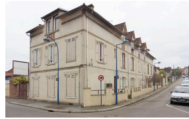
Vue d'ensemble de l'immeuble. Phot. Roselyne Bussière IVR11_20187800794NUC4A
