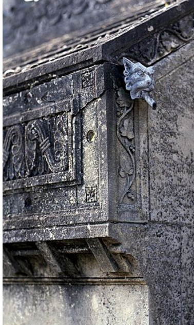
Détail : petite gargouille à l'arrière de la chapelle. Phot. Stéphane Asseline IVR11_20037700140XA
