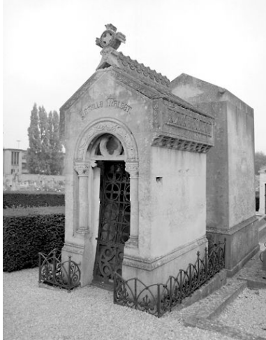
Vue d'ensemble. La grille en fonte porte la signature de Bardoux (Deuil). Phot. Stéphane Asseline IVR11_20027700839X
