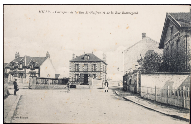
Carte postale ancienne montrant le carrefour entre la rue du Faubourg Saint-Wulfran et la rue Beauregard (Coll. particulière). IVR11_20269100141NUC4A
