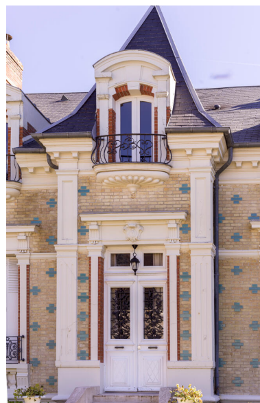
Vue de la travée centrale.
