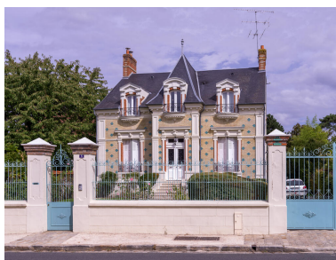
Vue générale depuis l'ouest. Phot. Asseline Stéphane IVR11_20259100822NUC4A
