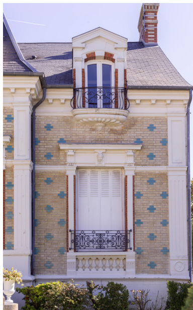
Vue de la travée sud. Phot. Asseline Stéphane IVR11_20269100110NUC4A
