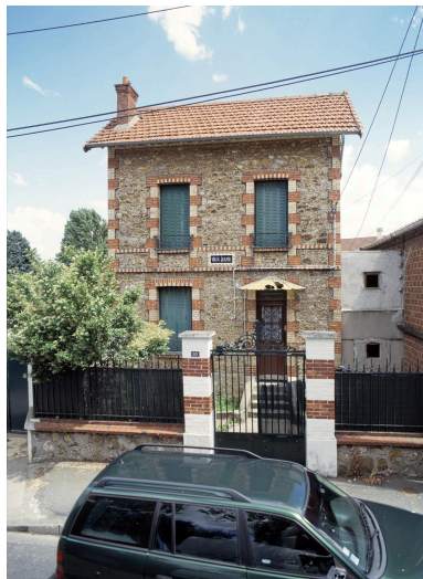
Vue d'ensemble. Phot. Philippe Ayrault IVR11_20049100473XA
