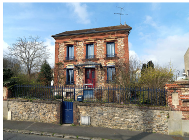
Vue d'ensemble, depuis la rue. Phot. Jean-Bernard Vialles IVR11_20179500021NUC4A
