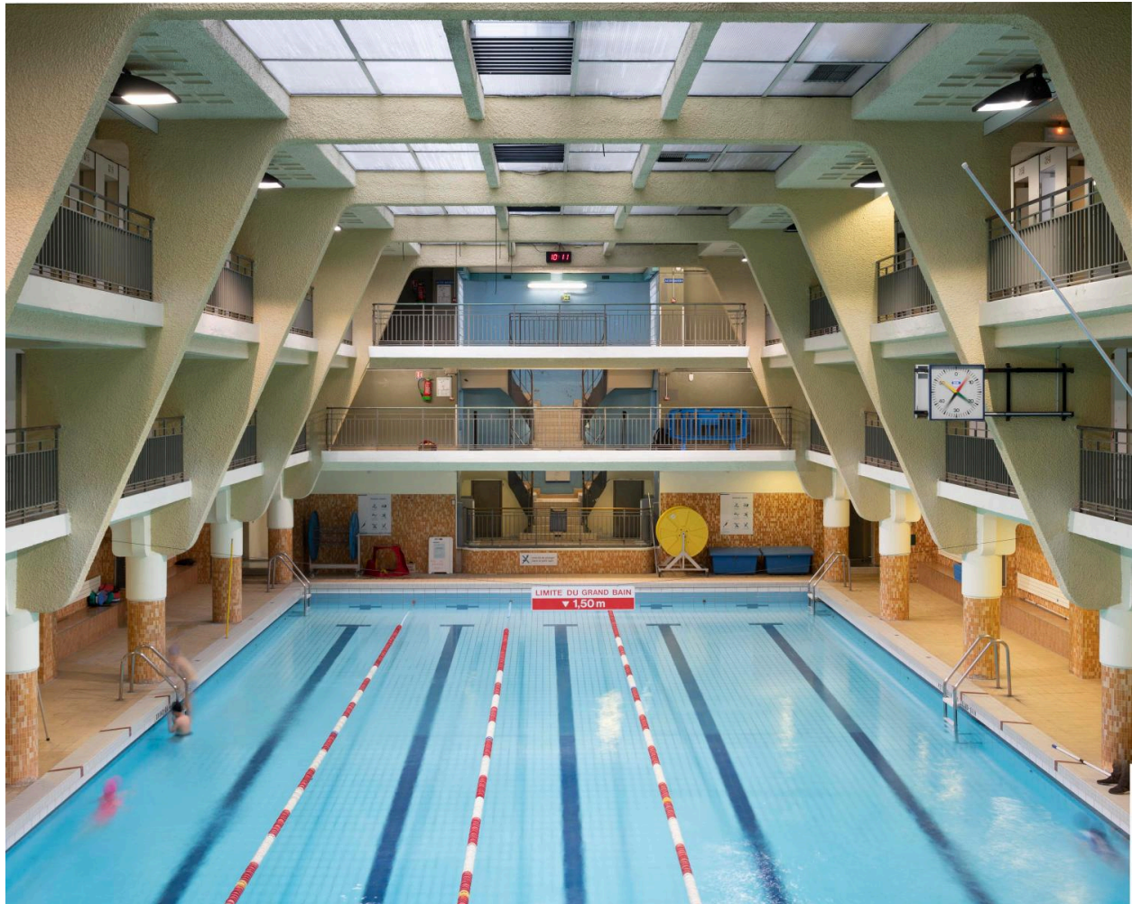
Vue intérieure de la piscine Rouvet
