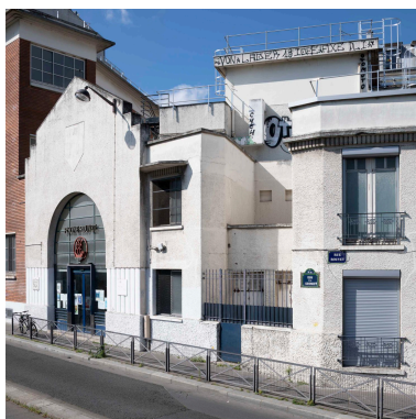
Elévations sur rue de la piscine Rouvet comprenant l'entrée principale et le logement du gardien. Phot. Philippe Ayrault IVR11_20227500371NUC4A
