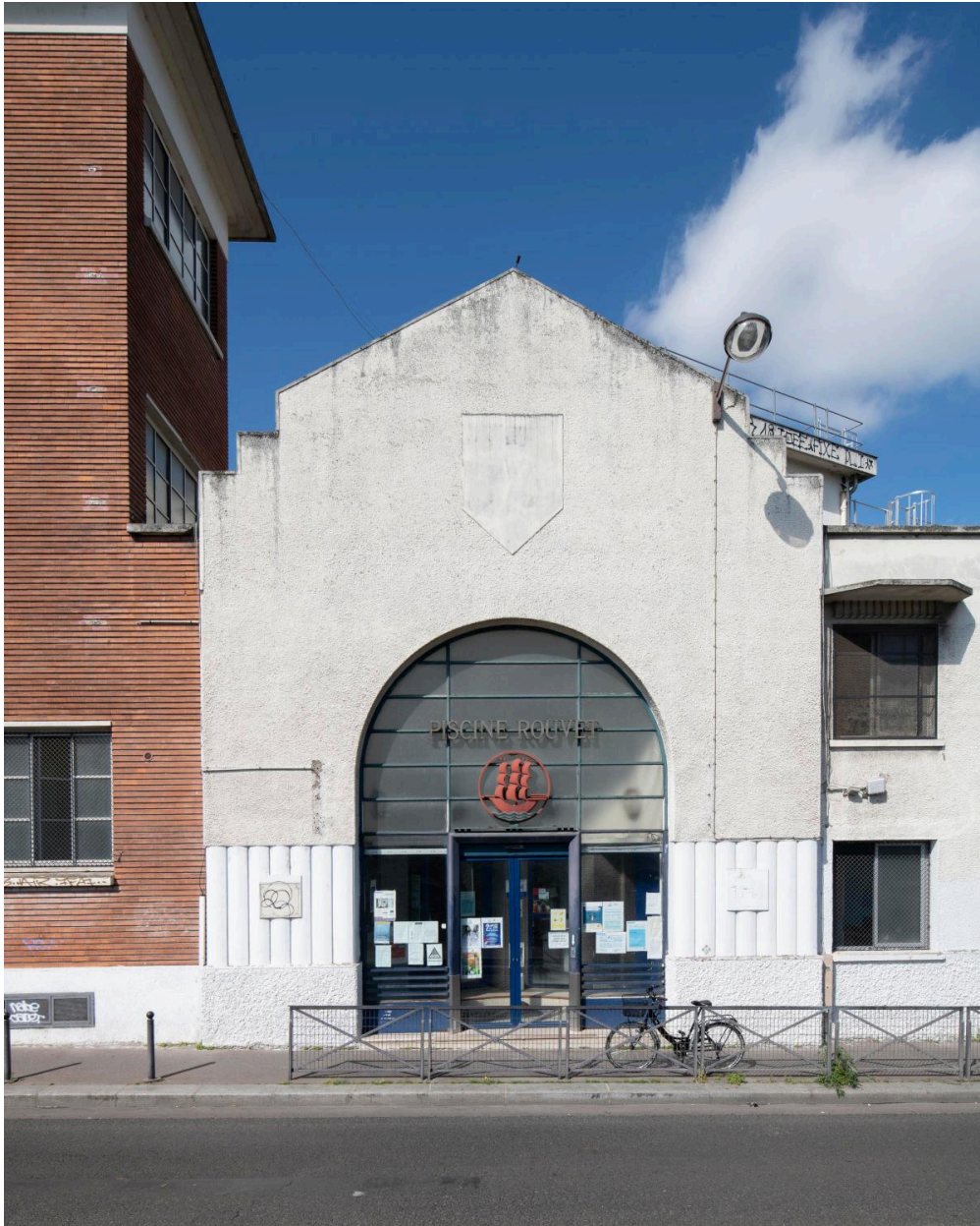
Façade sur la rue de la piscine Rouvet.
