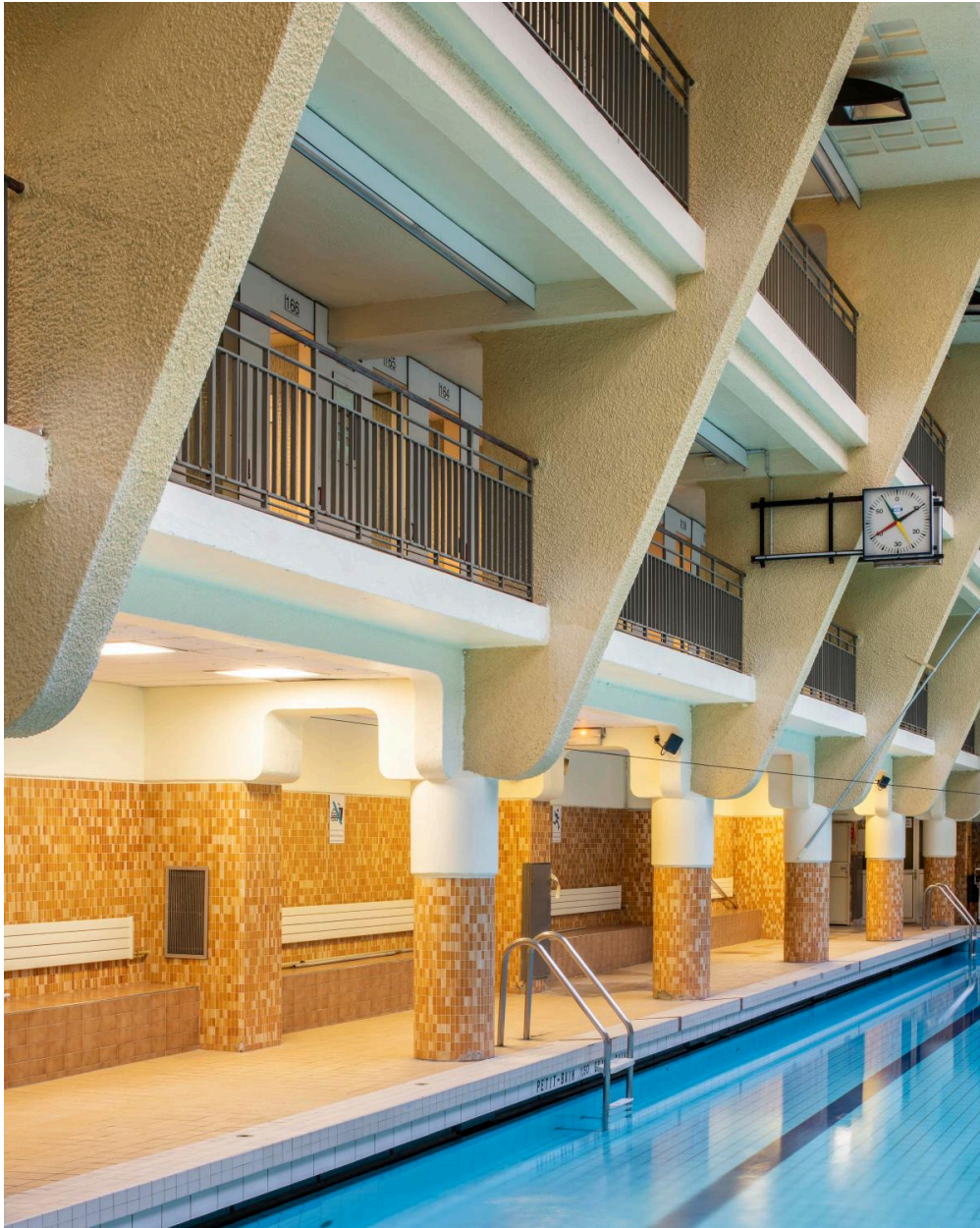
Vue des coursives de la piscine Rouvet
