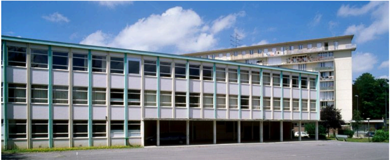
Ecole primaire : façade sur la cour.
