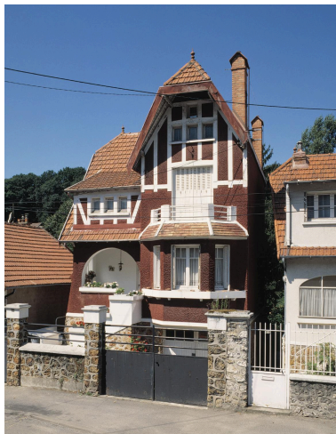
La façade sur rue. Phot. Stéphane Asseline IVR11_20017800027XA
