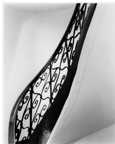
Vue de la partie tournante de la rampe. Photographie, 2000. (Collection particulière. Photographies P. Sébert) Phot. Laurent Kruszyk, Autr. Philippe (photographe) Sébert IVR11_20097500353NUC2B
