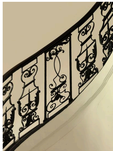
Détail des balustres rampants et d'un pilastre central. Phot. Laurent Kruszyk IVR11_20107500206NUC4A
