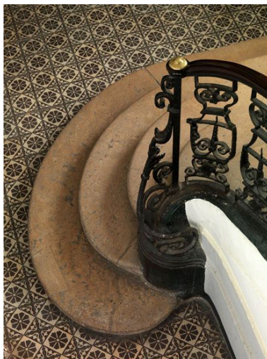
Vue du départ de l'escalier. Phot. Laurent Kruszyk IVR11_20107500204NUC4A
