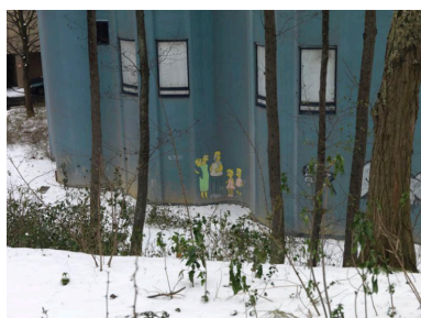
Vue de la partie inférieure de la tour. Phot. Laurent Kruszyk IVR11_20129500012NUC4A
