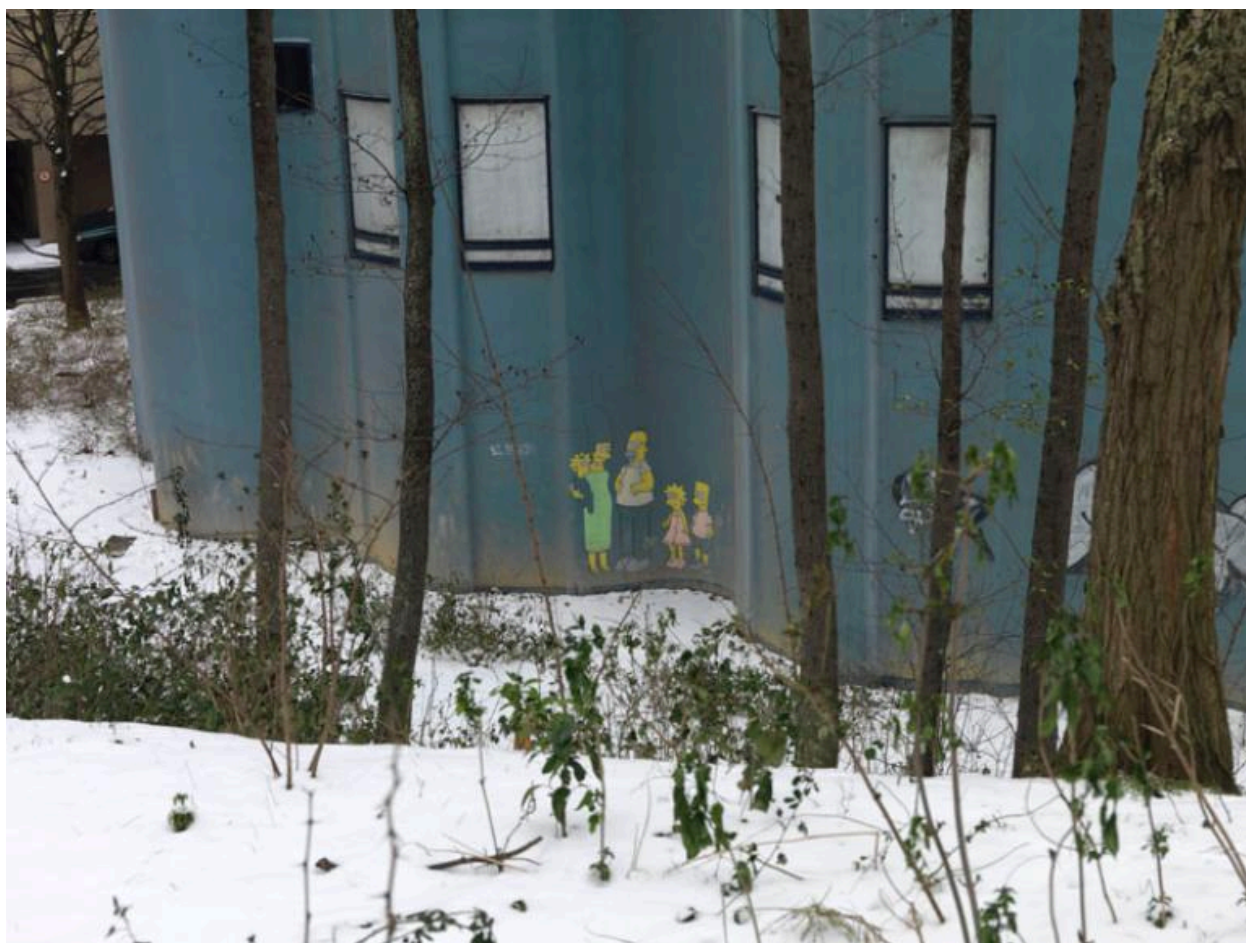
Vue de la partie inférieure de la tour.
