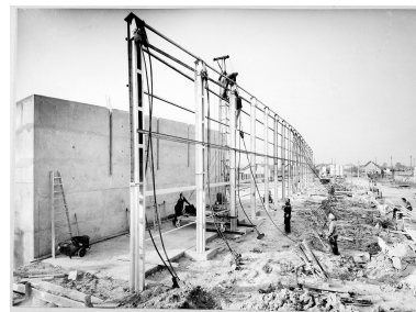
Construction du centre commercial (première charpente à câble en France, architecte Jean Heckly). 1961. IVR11_20019100758NUCB
