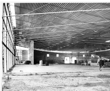
Autre vue du bâtiment en cours de construction. 1961. IVR11_20019100760NUCB
