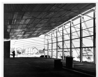
Vue du bâtiment en cours de construction. 1961. IVR11_20019100759NUCB
