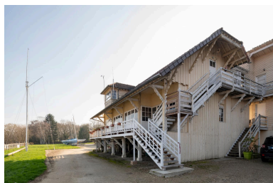
Détail du bâtiment en pan de bois du club-house avec ses escaliers extérieurs permettant l'accès au balcon principal, d'où regarder les compétitions de voile. Phot. Laurent Kruszyk IVR11_20227800113NUC4
