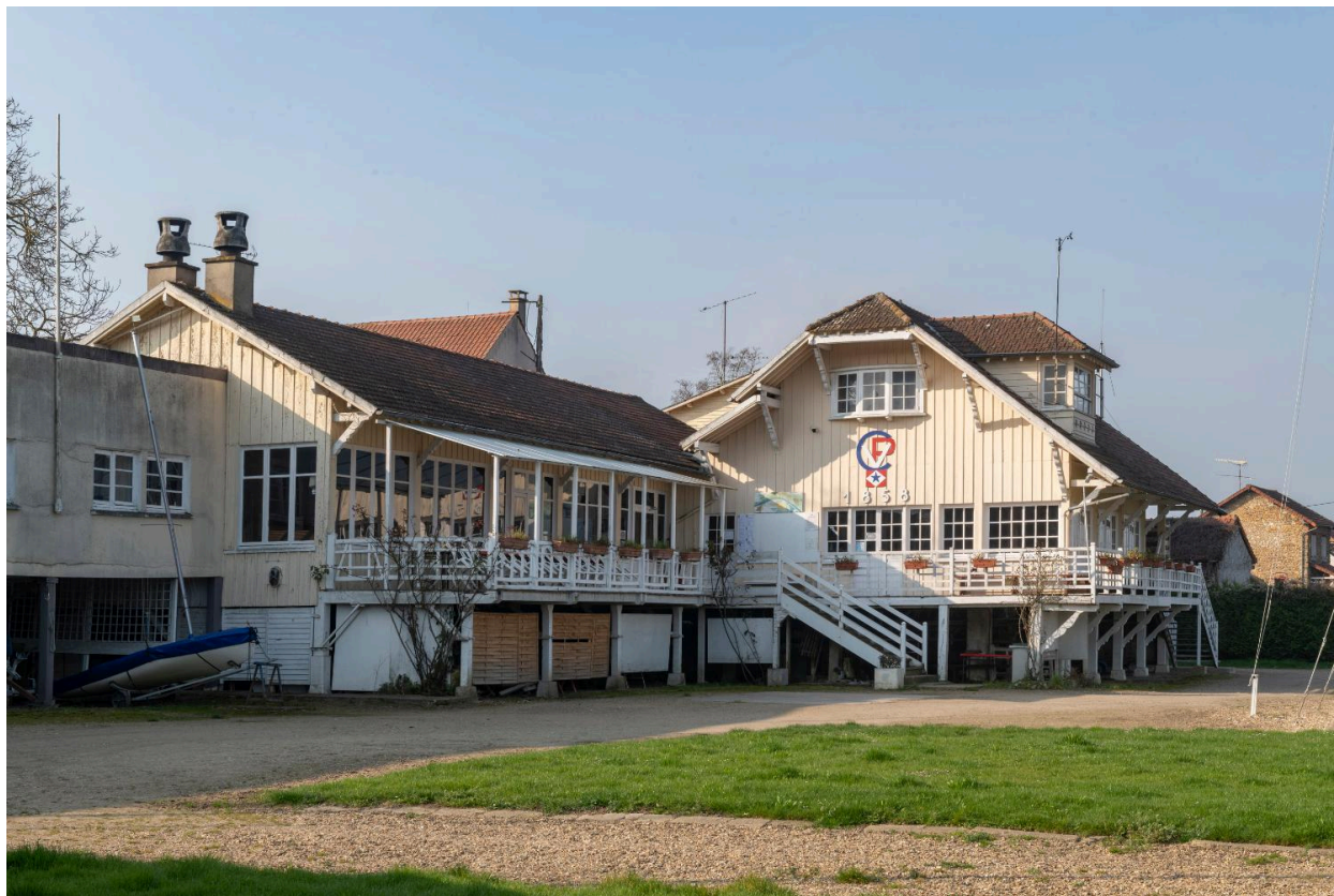
Vue générale du club-house du Cercle de la Voile de Paris.
