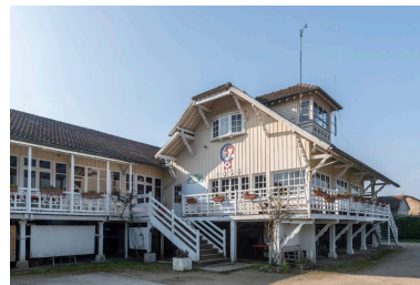
Vue latérale du club-house. Phot. Laurent Kruszyk IVR11_20227800112NUC4
