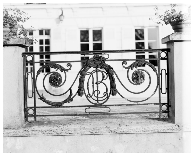
Détail du garde-corps portant un monogramme. Phot. Vialles Jean-Bernard IVR11_19919100021X
