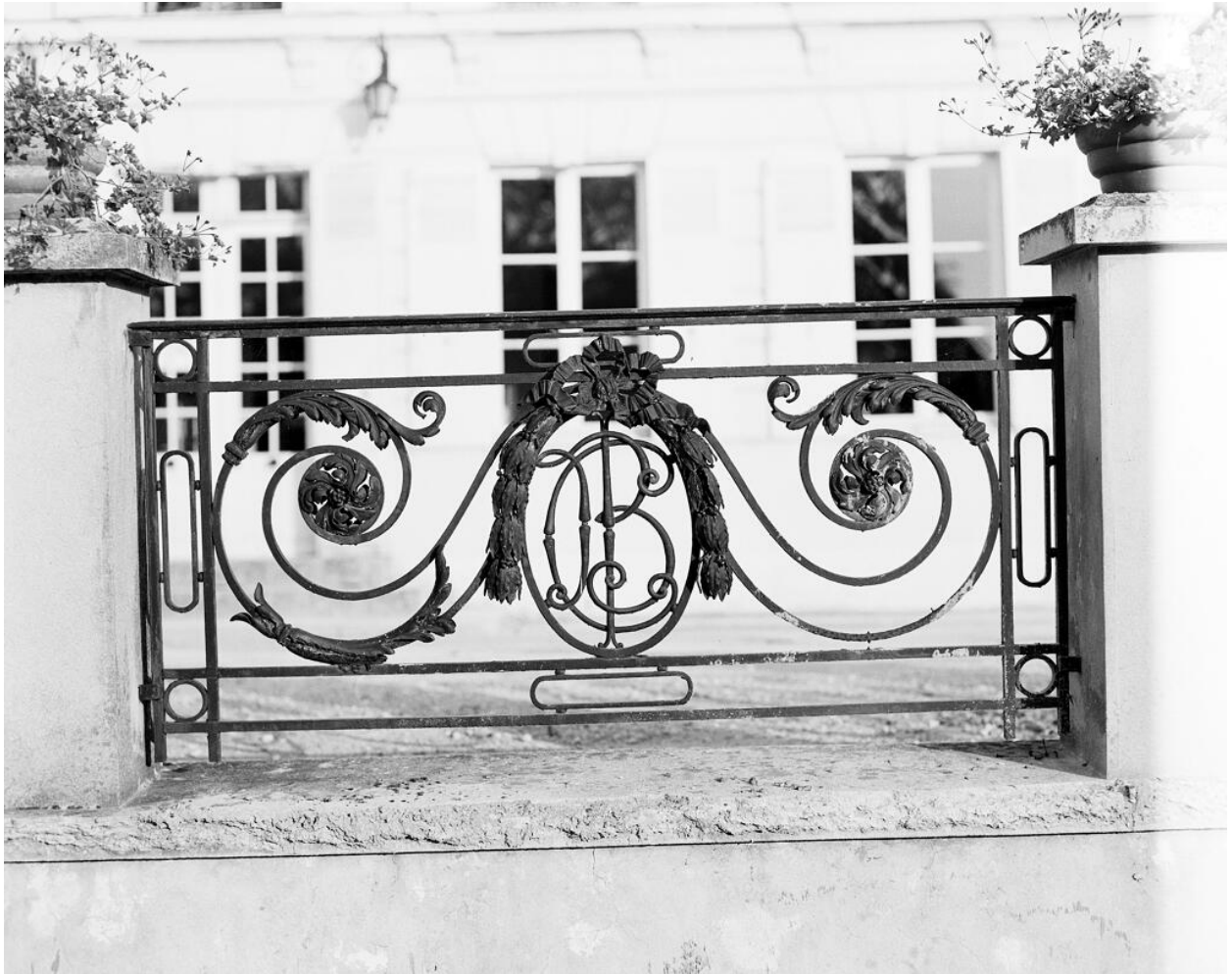
Détail du garde-corps portant un monogramme.
