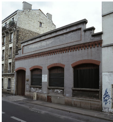
Vue générale depuis la rue. Phot. Jean-Bernard Vialles IVR11_20009300194XA
