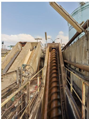
Zone du traitement des eaux (Unité 420). Vis sans fin de la chaîne huileuse (premier traitement mécanique pour séparer l'eau des hydrocarbures). À gauche, les deux autres vis de la chaîne process (eau issue du dessalage du pétrole brut).
