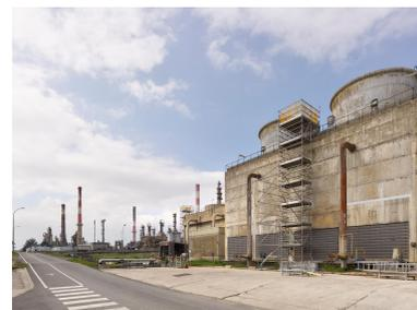
Zone du traitement des eaux (Unité 420). Tour aéroréfrigérante "SCAM", utilisée pour refroidir
