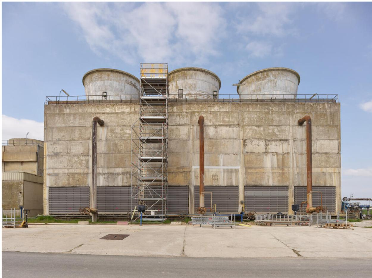
Zone du traitement des eaux (Unité 420). Tour aéroréfrigérante "SCAM", utilisée pour refroidir les eaux procédées pour le fonctionnement des Unités Ouest.
