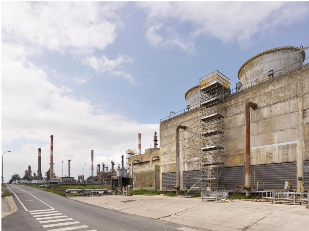
Zone du traitement des eaux (Unité 420). Tour aéroréfrigérante "SCAM", utilisée pour refroidir les eaux procédées pour le fonctionnement des Unités Est.
