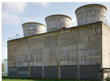
Zone du traitement des eaux (Unité 420). Tour aérorefrigérante "SCAM", utilisée pour refroidir les eaux procédées pour le fonctionnement des Unités Ouest.
