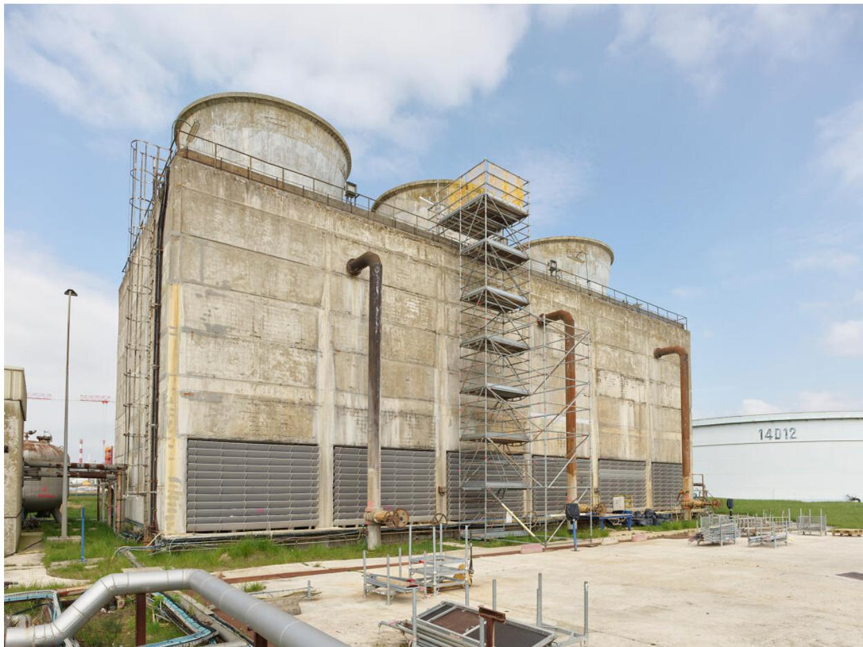
Zone du traitement des eaux (Unité 420). Tour aéroréfrigérante "SCAM", utilisée pour refroidir les eaux procédées pour le fonctionnement des Unités Ouest. Au fond à droite, bac de réserve d'eau incendie (20 000 m<sup>3</sup>).
