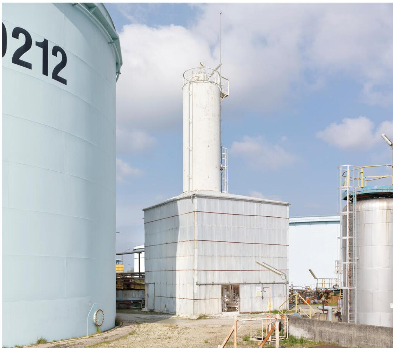
Zone du traitement des eaux (Unité 420). Local à chaux, produit chimique utilisé pour les décarbonateurs et pour faire remonter le pH de l'eau traitée.
