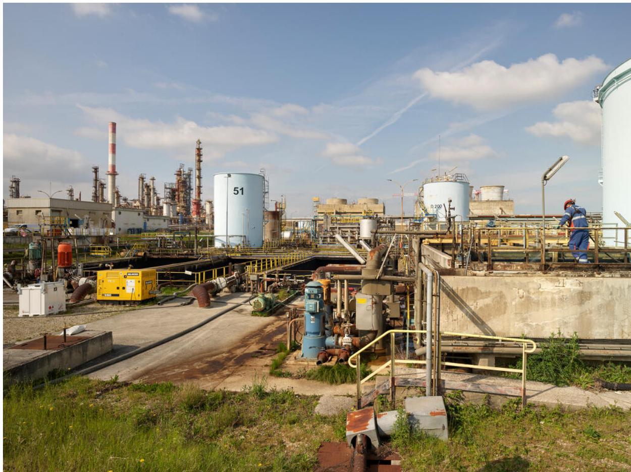
Zone du traitement des eaux (Unité 420). L'opérateur à droite contrôle les goulottes d'écumage des chaînes API (chaînes de séparation d'eaux et d'hydrocarbures).
