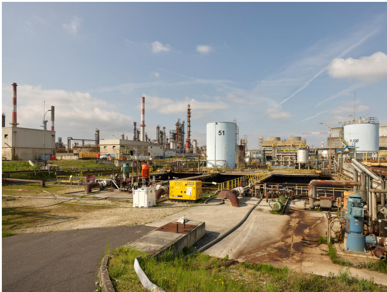
Zone du traitement des eaux (Unité 420). Vue générale.
