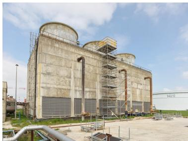
Zone du traitement des eaux (Unité 420). Tour aérorefrigérante "SCAM", utilisée pour refroidir les eaux procédées pour le fonctionnement des Unités Ouest. Au fond à droite, bac de réserve d'eau incendie (20 000 m<sup>3</sup>).
