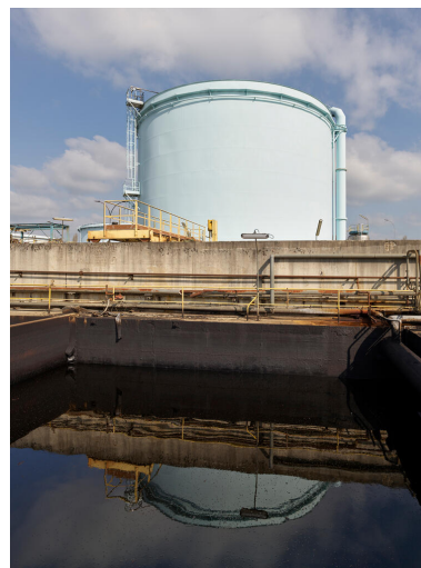
Zone du traitement des eaux (Unité 420). Bassin d'orage (déversoir en cas de débordement). Phot. Stéphane Asseline, Phot. Stéphane Asseline IVR11_20237700383NUC4A
