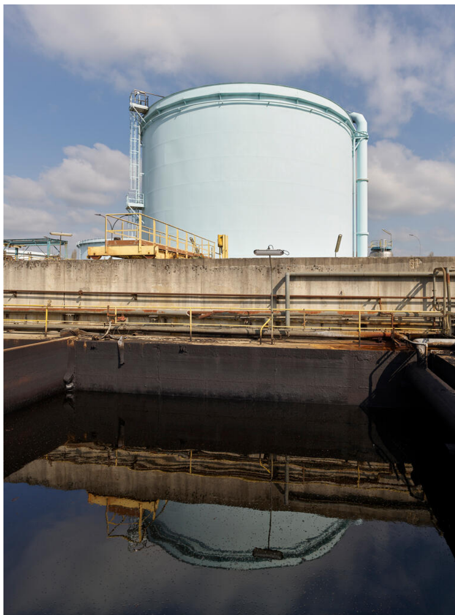
Zone du traitement des eaux (Unité 420). Bassin d'orage (déversoir en cas de débordement).
