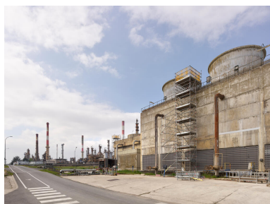
Zone du traitement des eaux (Unité 420). Tour aéroréfrigérante "SCAM", utilisée pour refroidir les eaux procédé pour le fonctionnement des Unités Est. Phot. Stéphane Asseline, Phot. Stéphane Asseline IVR11_20237700375NUC4A
