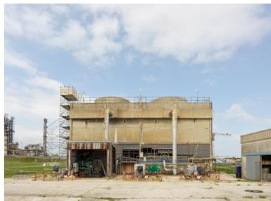
Zone du traitement des eaux (Unité 420). Tour aérorefrigérante "SCAM", utilisée pour refroidir les eaux procédées pour le fonctionnement des Unités Est.
