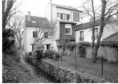
Vue des façades arrières donnant sur la Bièvre. Phot. Christian Décamps IVR11_20007800108X
