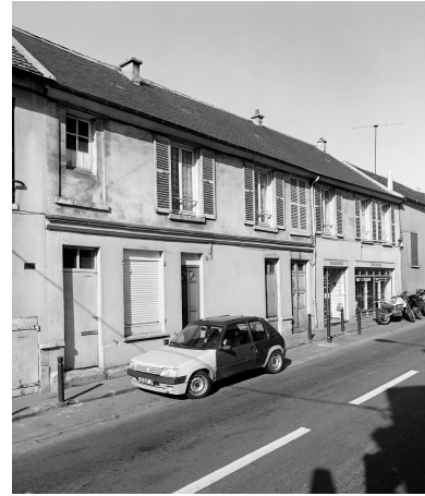
Vue de la façade antérieure. Phot. Christian Décamps IVR11_20007800116X
