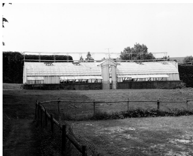
La serre, vue latérale. Phot. Vialles Jean-Bernard IVR11_19887800556X
