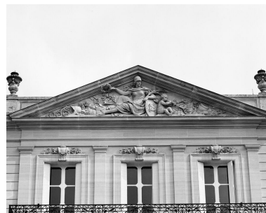
Détail du fronton sculpté de la façade postérieure. Phot. Vialles Jean-Bernard IVR11_19887800670X
