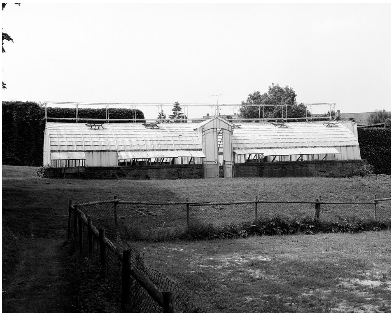
La serre, vue latérale.
