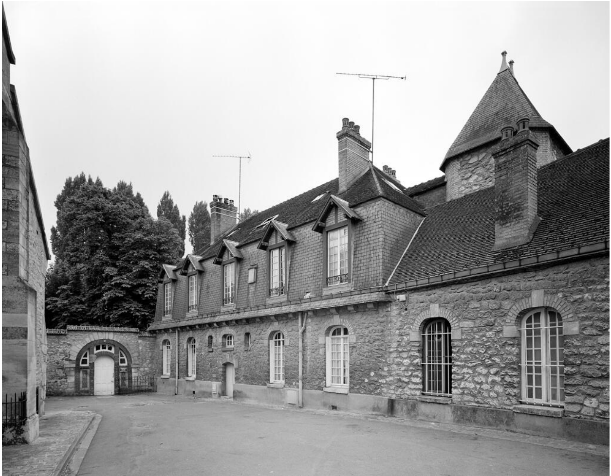
Les communs. Elévation sur la rue de l'Eglise.
