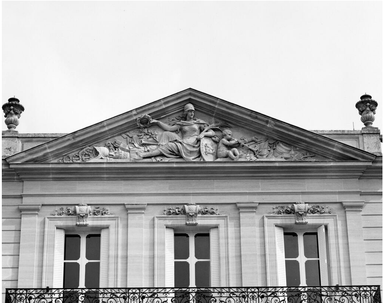
Détail du fronton sculpté de la façade postérieure.
