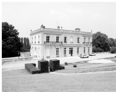
La façade antérieure, vue de trois-quarts. Phot. Vialles Jean-Bernard IVR11_19887800544X
