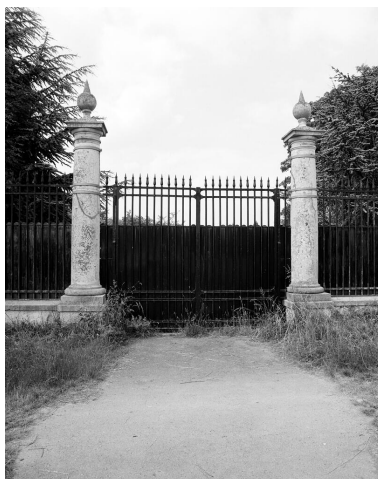
Détail de la partie centrale du portail. Phot. Vialles Jean-Bernard IVR11_19887800561X
