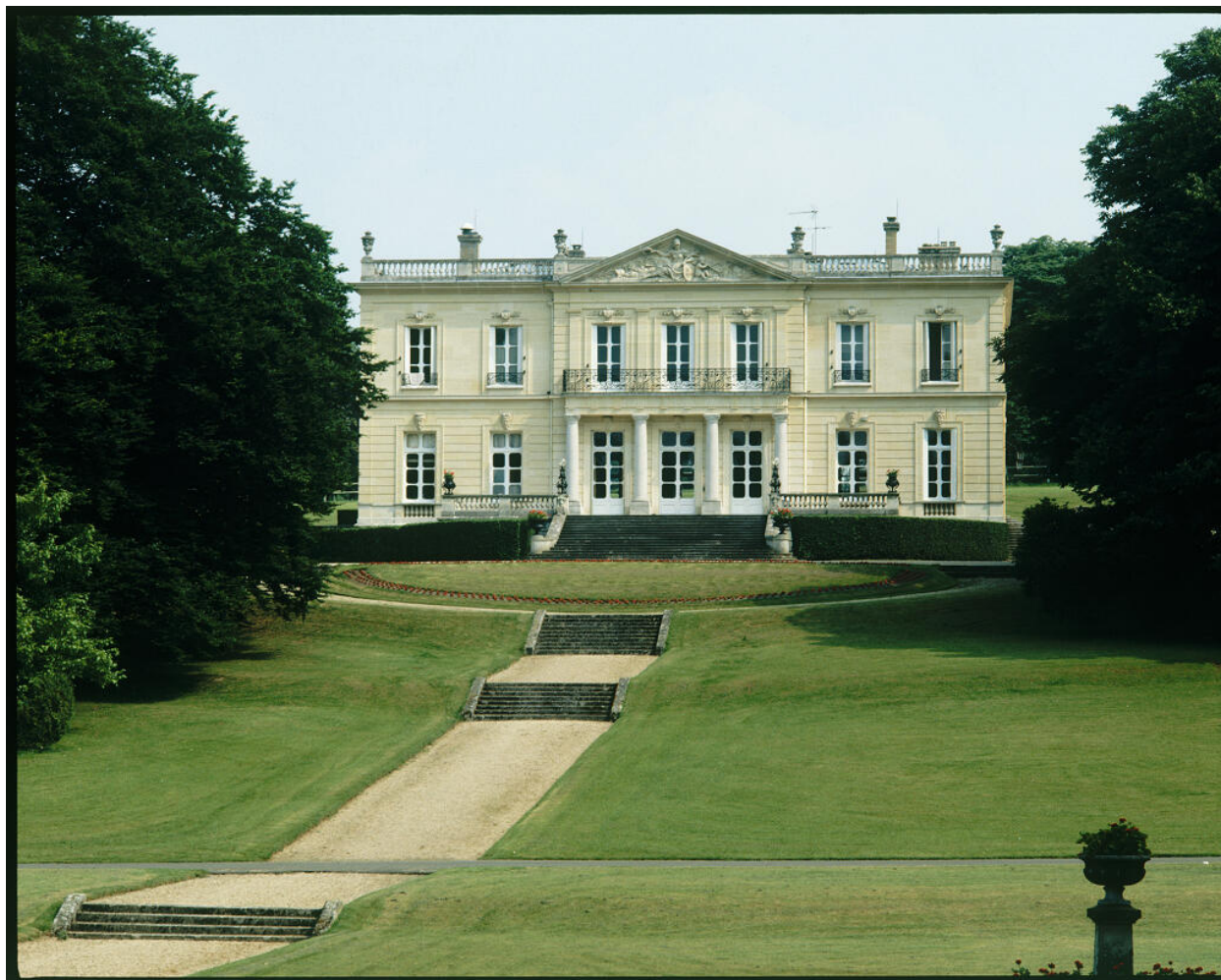
Face postérieure sur le parc.
