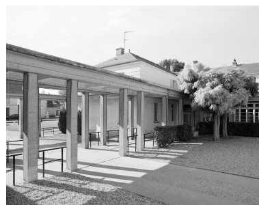
La galerie-portique vue de la cour de l'école. Phot. Philippe Ayrault IVR11_20019100539X
