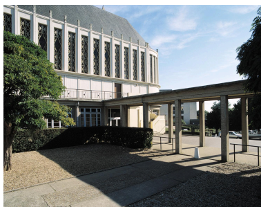
Le portique donnant accès à la cour d'école. Phot. Philippe Ayrault IVR11_20019100533XA
