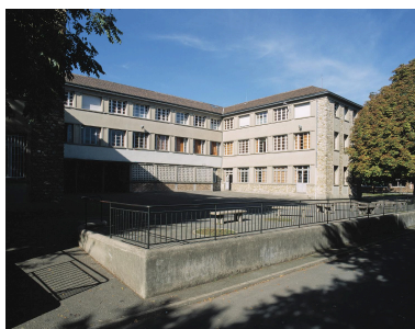
Façade postérieure du bâtiment scolaire construit en 1950. Phot. Philippe Ayrault IVR11_20019100546XA
