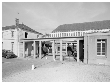
Vue d'ensemble de la double galerie-portique qui donne accès à la cour de l'école. Phot. Philippe Ayrault IVR11_20019100541X
