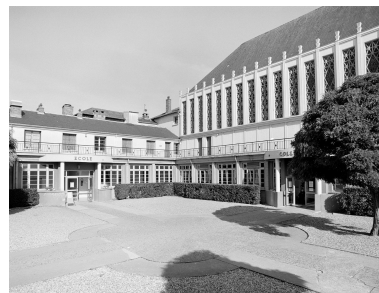
Vue d'ensemble de la cour bordée par l'école et par la chapelle. Phot. Philippe Ayrault IVR11_20019100531X
