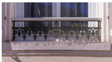
Vue de détail d'un garde-corps. Phot. Asseline Stéphane IVR11_20269100105NUC4A
