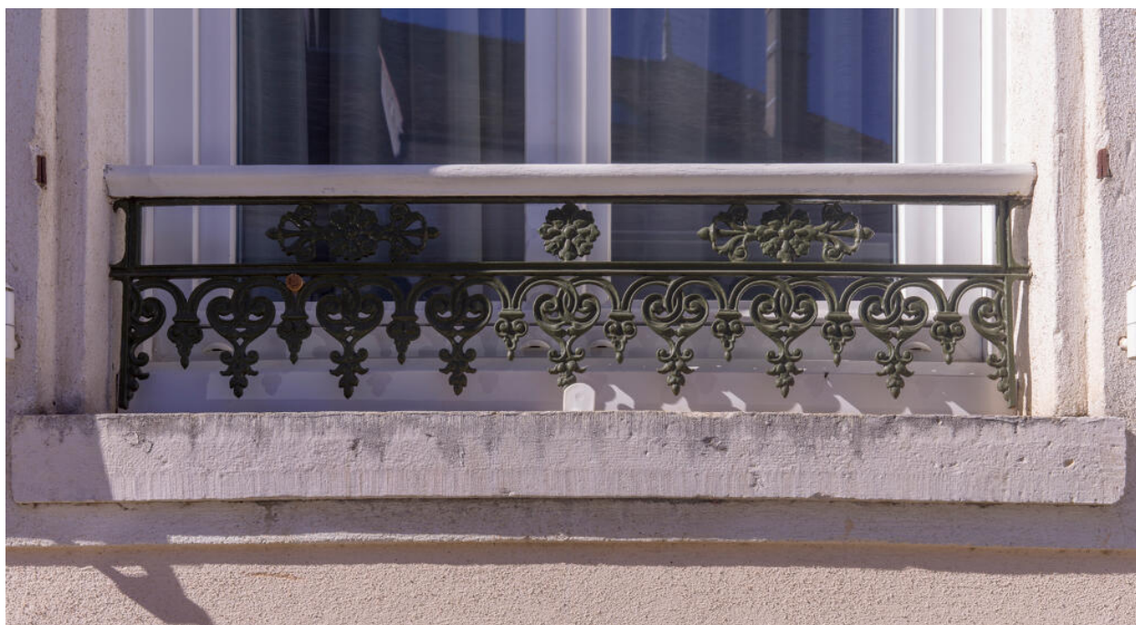
Vue de détail d'un garde-corps.
