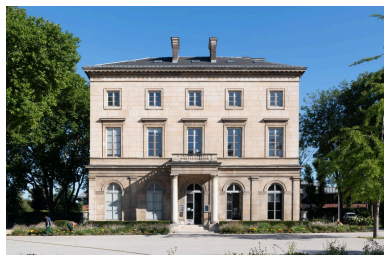
Façade principale, sud-est Phot. Laurent Kruszyk IVR11_20229300581NUC4A
