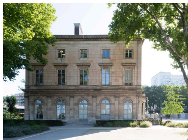
Façade latérale ouest Phot. Laurent Kruszyk IVR11_20229300585NUC4A
