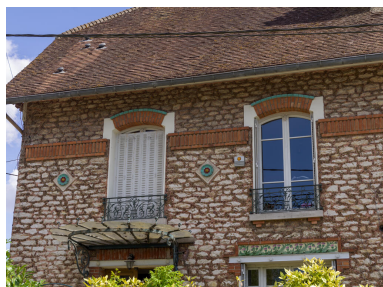
Niveau supérieur de la façade du 25 rue Saint-Pierre. Phot. Asseline Stéphane IVR11_20259100733NUC4A
