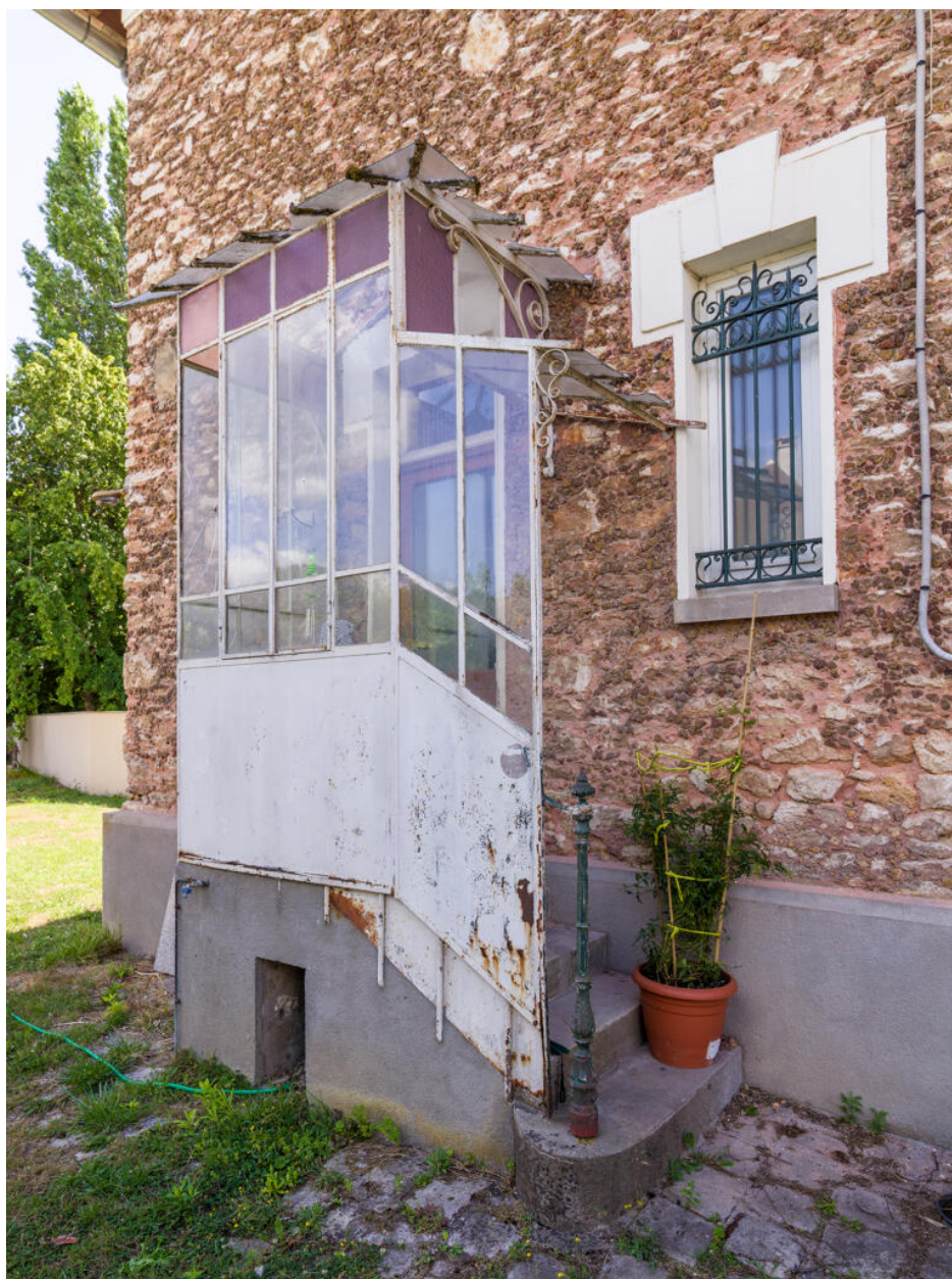
Partie basse du pignon du 25 rue Saint-Pierre.
