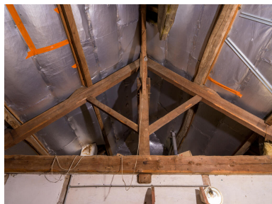
Vue générale de la charpente du 25 rue Saint-Pierre. Phot. Asseline Stéphane IVR11_20259100769NUC4A
