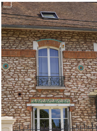
Vue de la travée ouest de la façade du 25 rue Saint-Pierre. Phot. Asseline Stéphane IVR11_20259100734NUC4A
