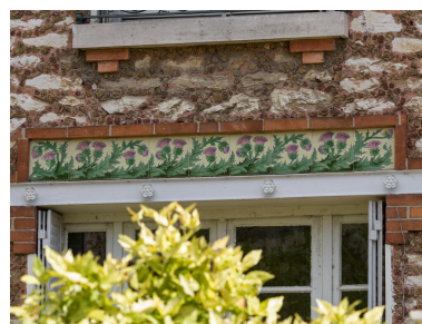
Vue du linteau de la baie du rez-de-chaussée du 25 rue Saint-Pierre. Phot. Asseline Stéphane IVR11_20259100739NUC4A
