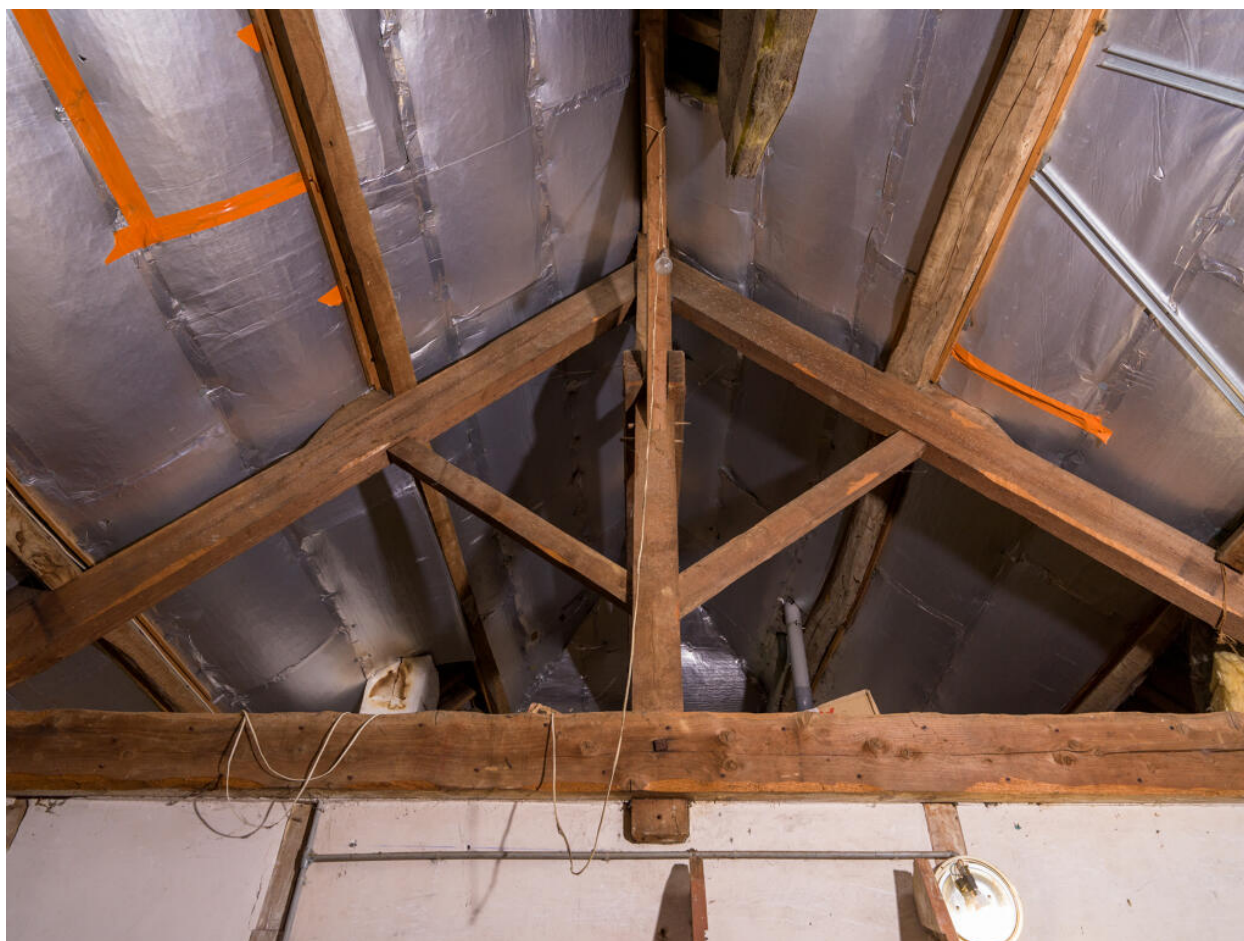
Vue générale de la charpente du 25 rue Saint-Pierre.
