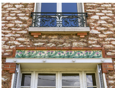
Détail de la façade du 25 rue Saint-Pierre. Phot. Asseline Stéphane IVR11_20259100735NUC4A
