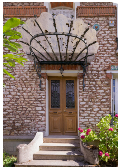
Vue générale de l'entrée du 25 rue Saint-Pierre. Phot. Asseline Stéphane IVR11_20259100736NUC4A
