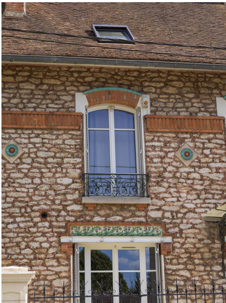
Vue de la travée ouest de la façade du 25 rue Saint-Pierre.
