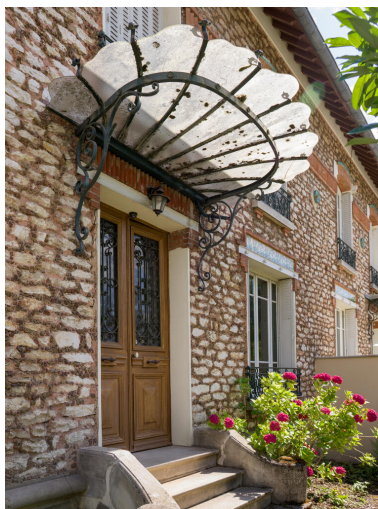
Vue de l'entrée du 25 rue Saint-Pierre depuis le nord-est. Phot. Asseline Stéphane IVR11_20259100737NUC4A
