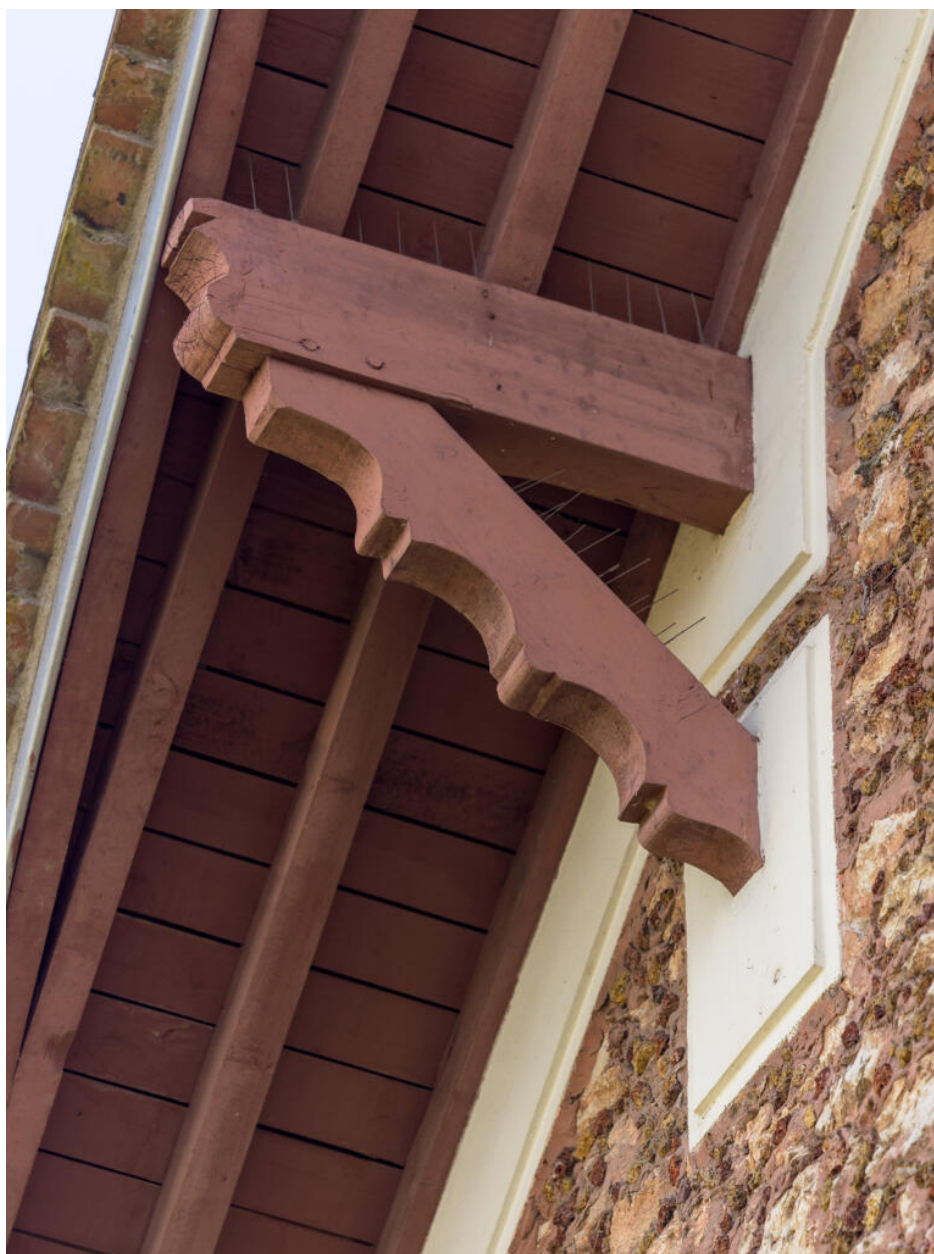
Vue d'un aisselier du pignon du 25 rue Saint-Pierre.
