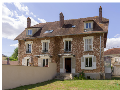
Vue générale des 25 et 27 rue Saint-Pierre depuis le sud-est. Phot. Asseline Stéphane IVR11_20259100740NUC4A
