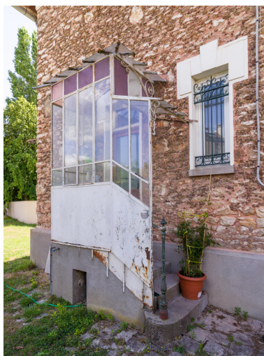
Partie basse du pignon du 25 rue Saint-Pierre. Phot. Asseline Stéphane IVR11_20259100742NUC4A
