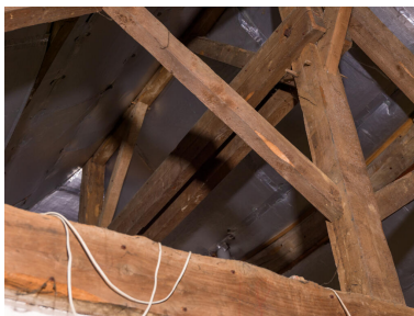
Détail de la charpente du 25 rue Saint-Pierre. Phot. Asseline Stéphane IVR11_20259100770NUC4A
