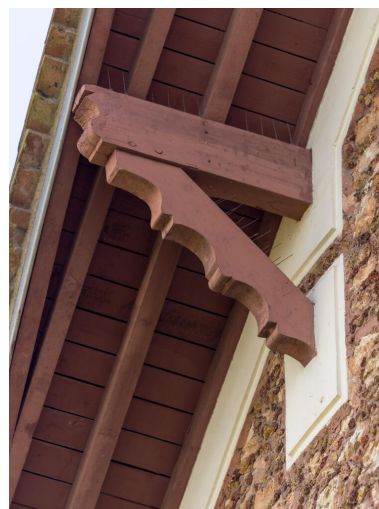
Vue d'un aisselier du pignon du 25 rue Saint-Pierre. Phot. Asseline Stéphane IVR11_20259100743NUC4A
