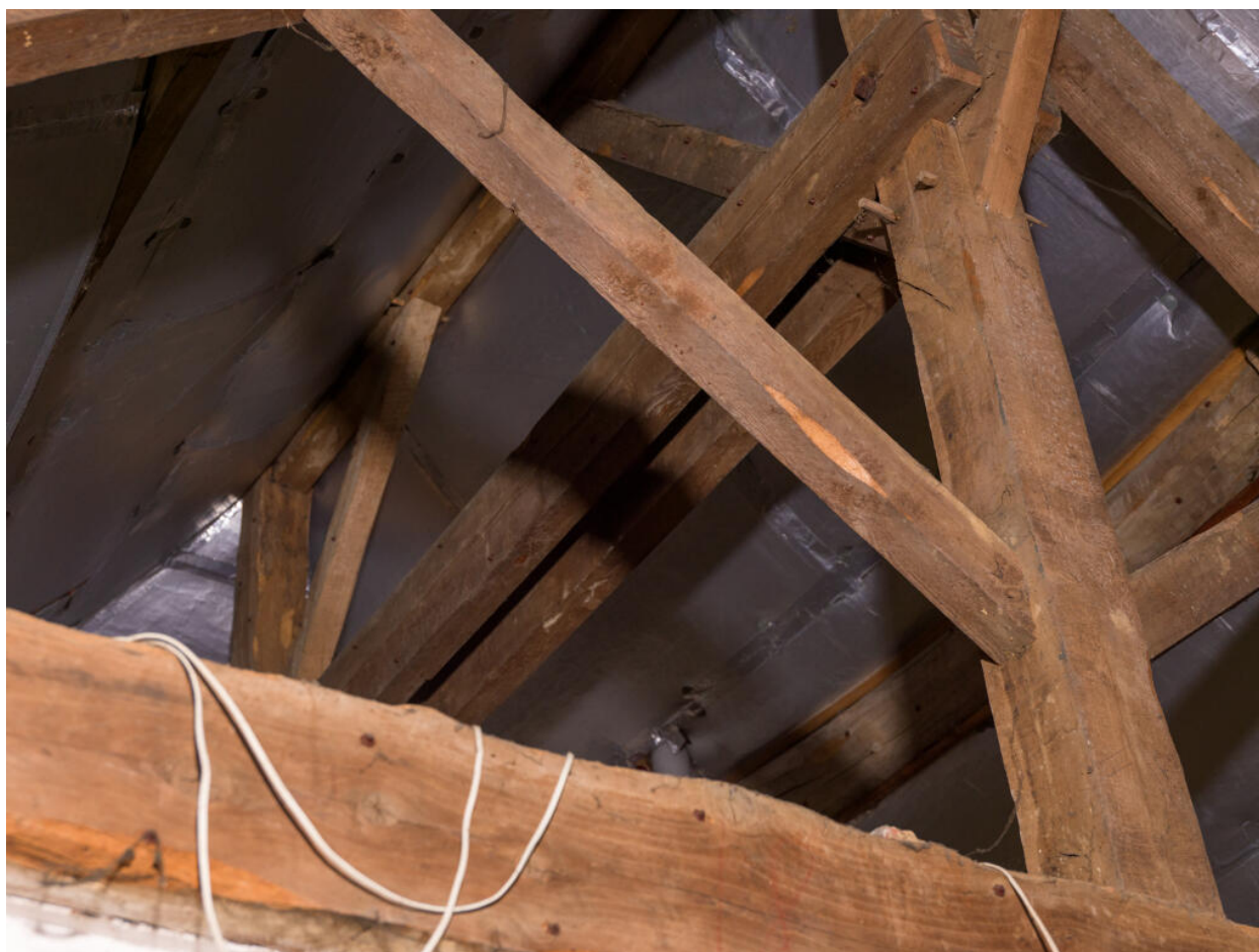
Détail de la charpente du 25 rue Saint-Pierre.
