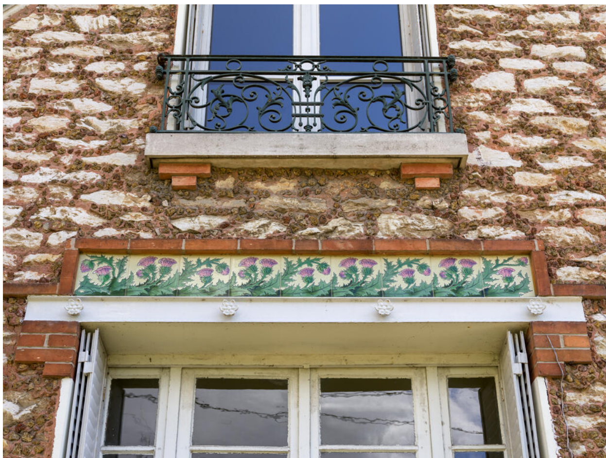
Détail de la façade du 25 rue Saint-Pierre.
