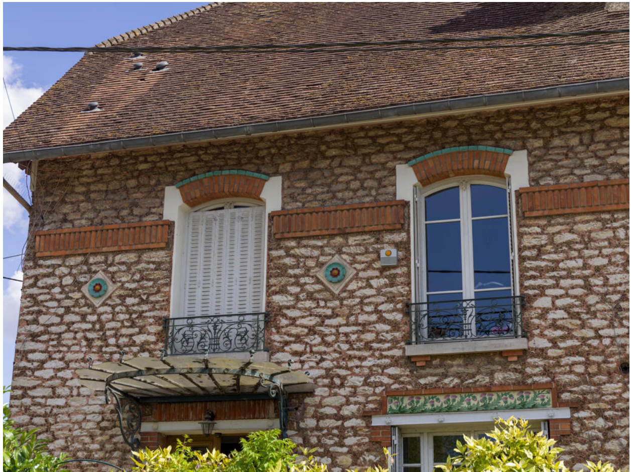
Niveau supérieur de la façade du 25 rue Saint-Pierre.
