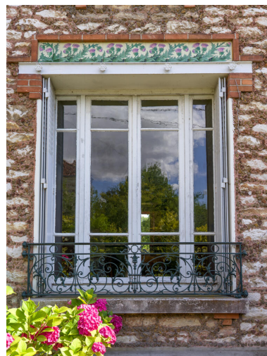
Baie du rez-de-chaussée du 25 rue Saint-Pierre. Phot. Asseline Stéphane IVR11_20259100731NUC4A
