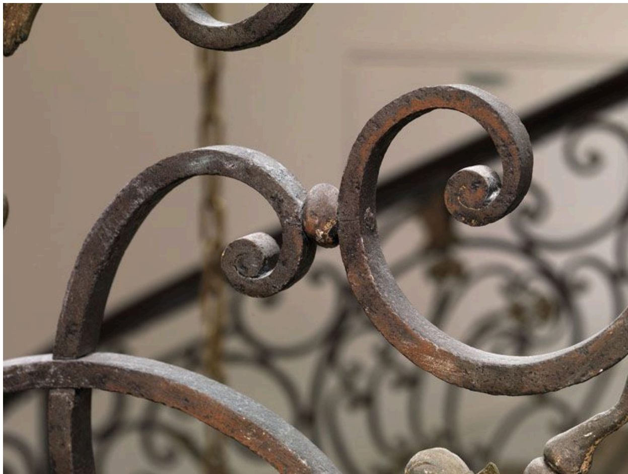
Détail d'un assemblage par bille.
