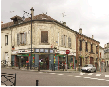
Vue d'ensemble. Phot. Philippe Ayrault IVR11_20189500032NUC4A
