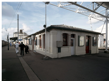
Annexe du premier bâtiment de voyageurs. Phot. Philippe Ayrault IVR11_20057800024XA
