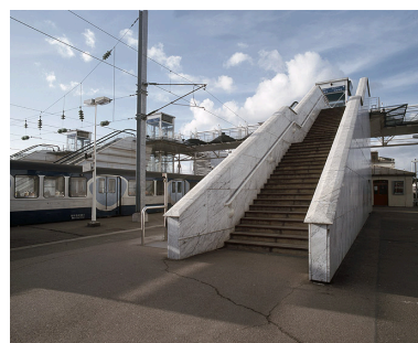
L'un des escaliers construits en 1995. Phot. Philippe Ayrault IVR11_20057800030XA
