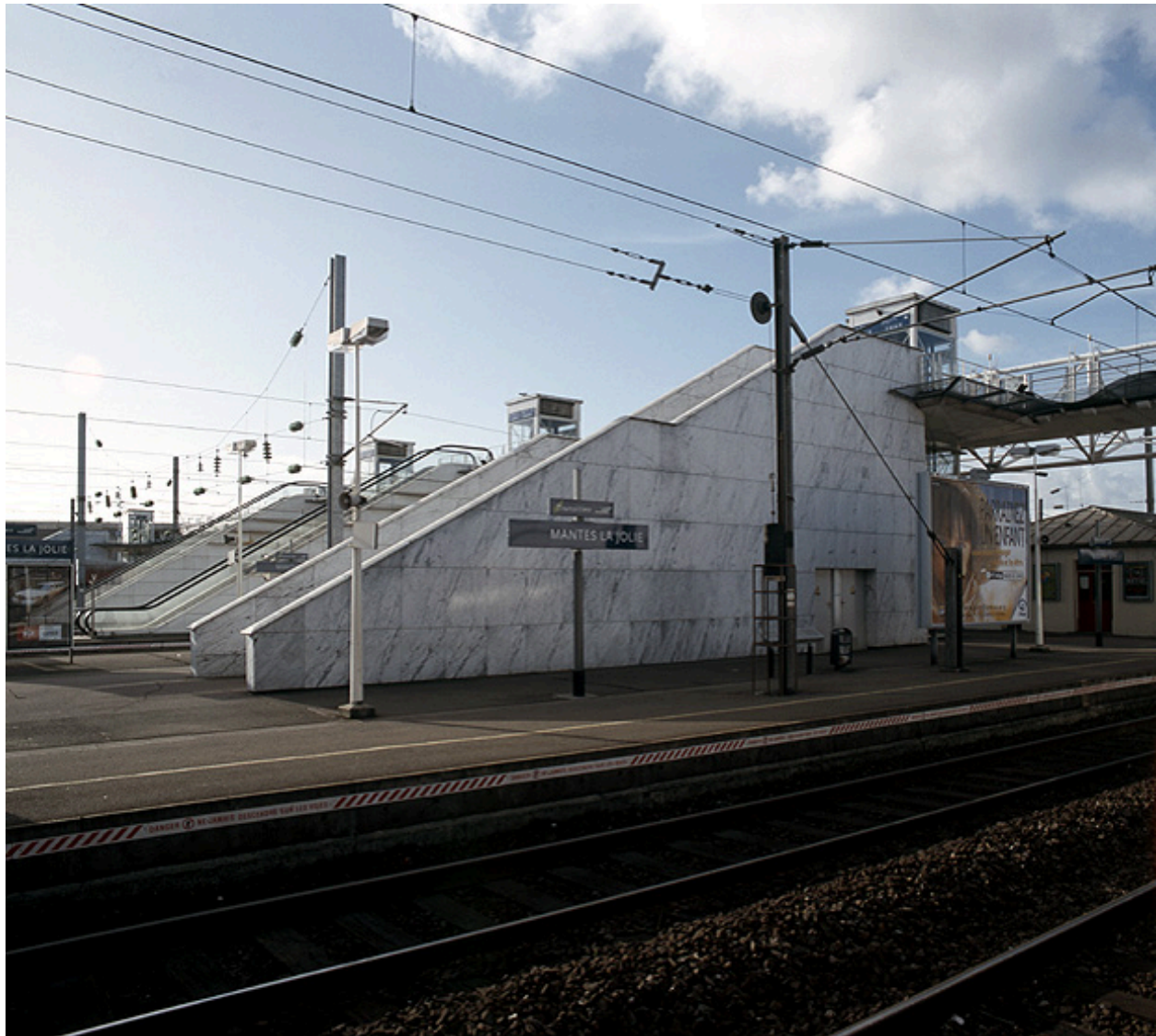
Escaliers et passerelle de 1995.
