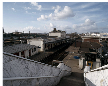
Vue des deux gares depuis la passerelle de 1995. Phot. Philippe Ayrault IVR11_20057800027XA
