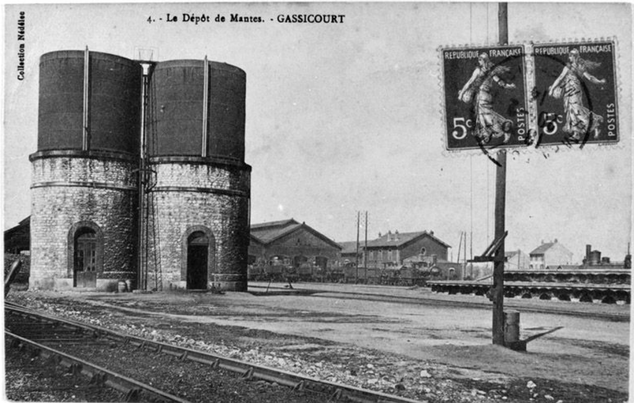
Vue du dépôt de Mantes. On aperçoit au premier plan deux réservoirs et à l'arrière la remise des locomotives, grande halle à charpente métallique. Carte postale (Région Ile-de-France. Fonds CREDOP)
