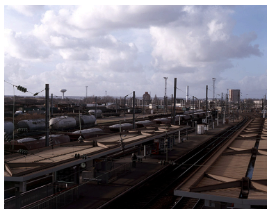
Vue sur les voies depuis la passerelle. Phot. Philippe Ayrault IVR11_20057800032XA
