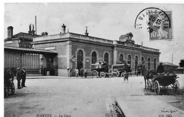
La façade de la gare. Carte postale (Région Ile-de-France. Fonds CREDOP)
