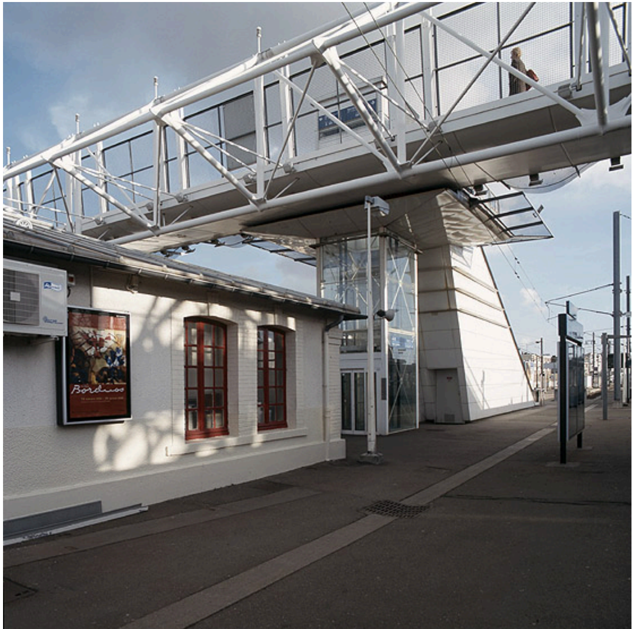
Annexe du premier bâtiment de voyageurs et passerelle construite en 1995.
