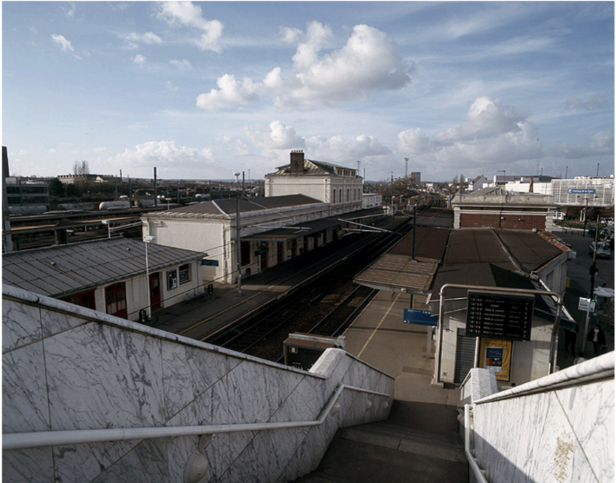
Vue des deux gares depuis la passerelle de 1995.
