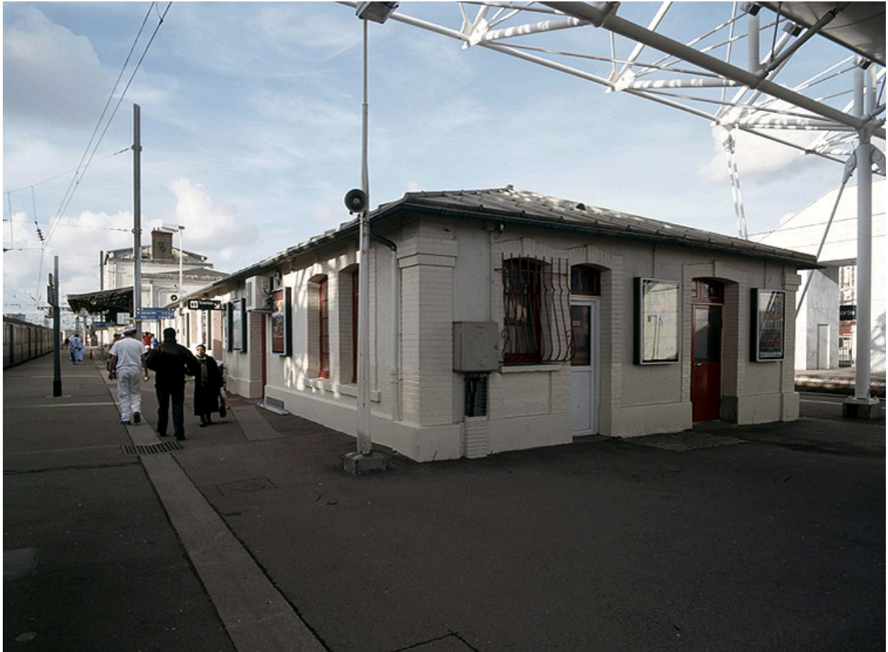
Annexe du premier bâtiment de voyageurs.
