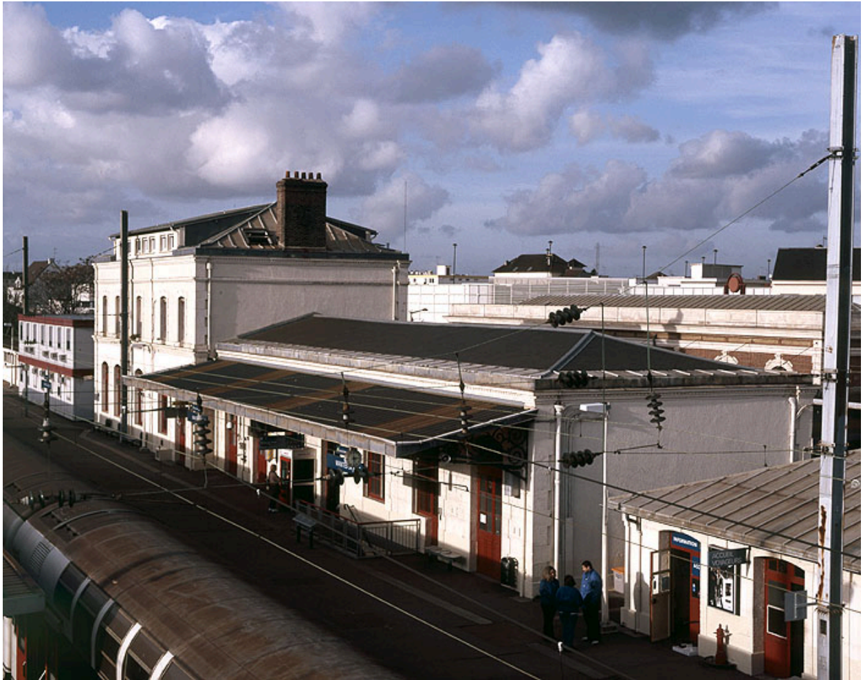
Vue d'ensemble de la gare de 1855 depuis la passerelle.
