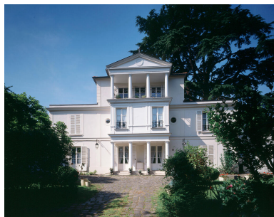
La façade antérieure. Phot. Ayrault Philippe IVR11_19949201150VA
