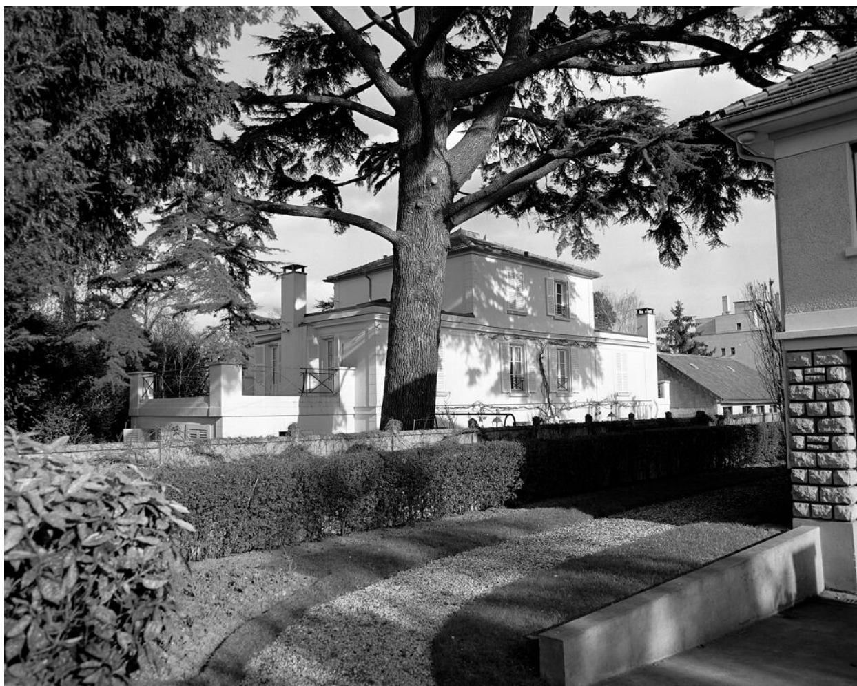
La façade postérieure.
