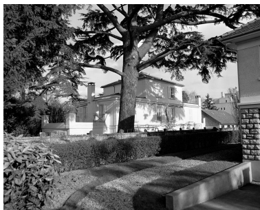
La façade postérieure. Phot. Ayrault Philippe IVR11_19949200281X
