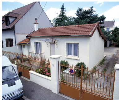
Vue d'ensemble. Phot. Philippe Ayrault IVR11_20049100466XA
