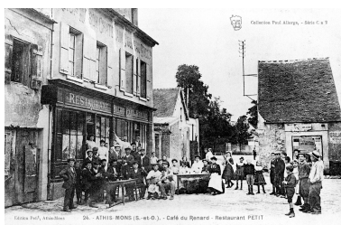
Vue du café-restaurant du vieil Athis. IVR11_20019100120X
