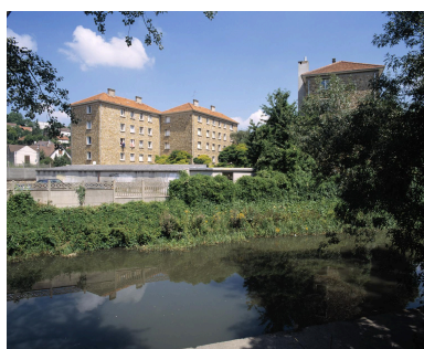
Vue des trois immeubles en meulière construits après la seconde guerre mondiale à l'emplacement de la cité provisoire de l'Orge. Au première plan : l'Orge. Phot. Philippe Ayrault IVR11_20029101072XA
