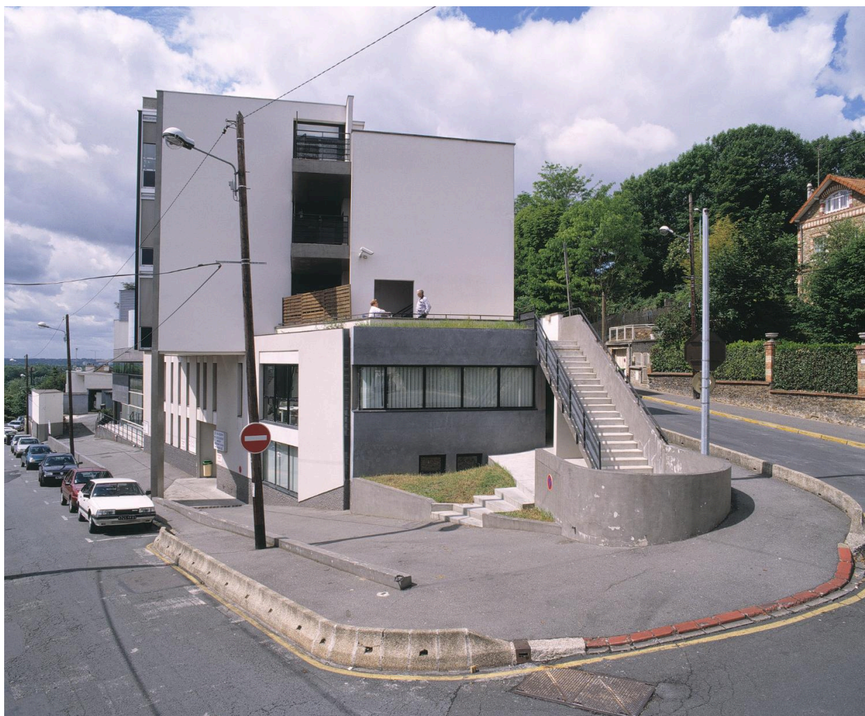
Vue du pignon, à l'angle des rues Caron et d'Ablon.
