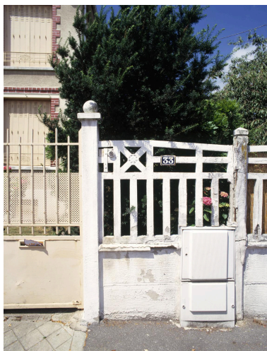
Clôture en ciment armé. Phot. Philippe Ayrault IVR11_20049100495XA
