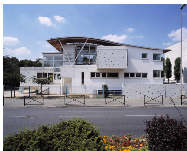
Vue d'ensemble. Phot. Philippe Ayrault IVR11_20039101013XA
