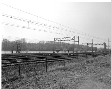
La voie ferrée le long de la rue Eugène-Raye prolongée. Phot. Philippe Ayrault IVR11_20029100450X
