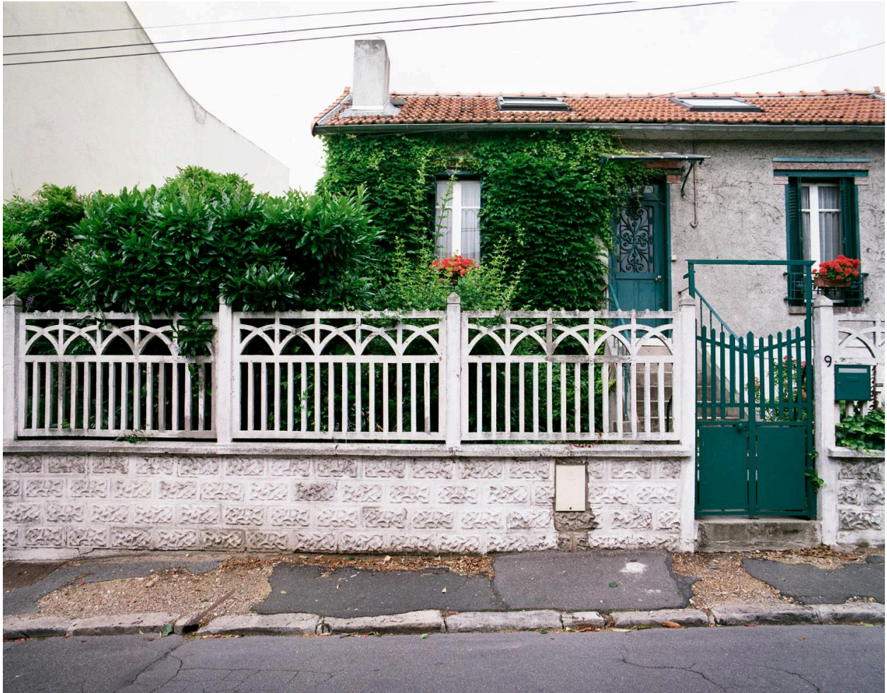
Clôture en ciment armé.
