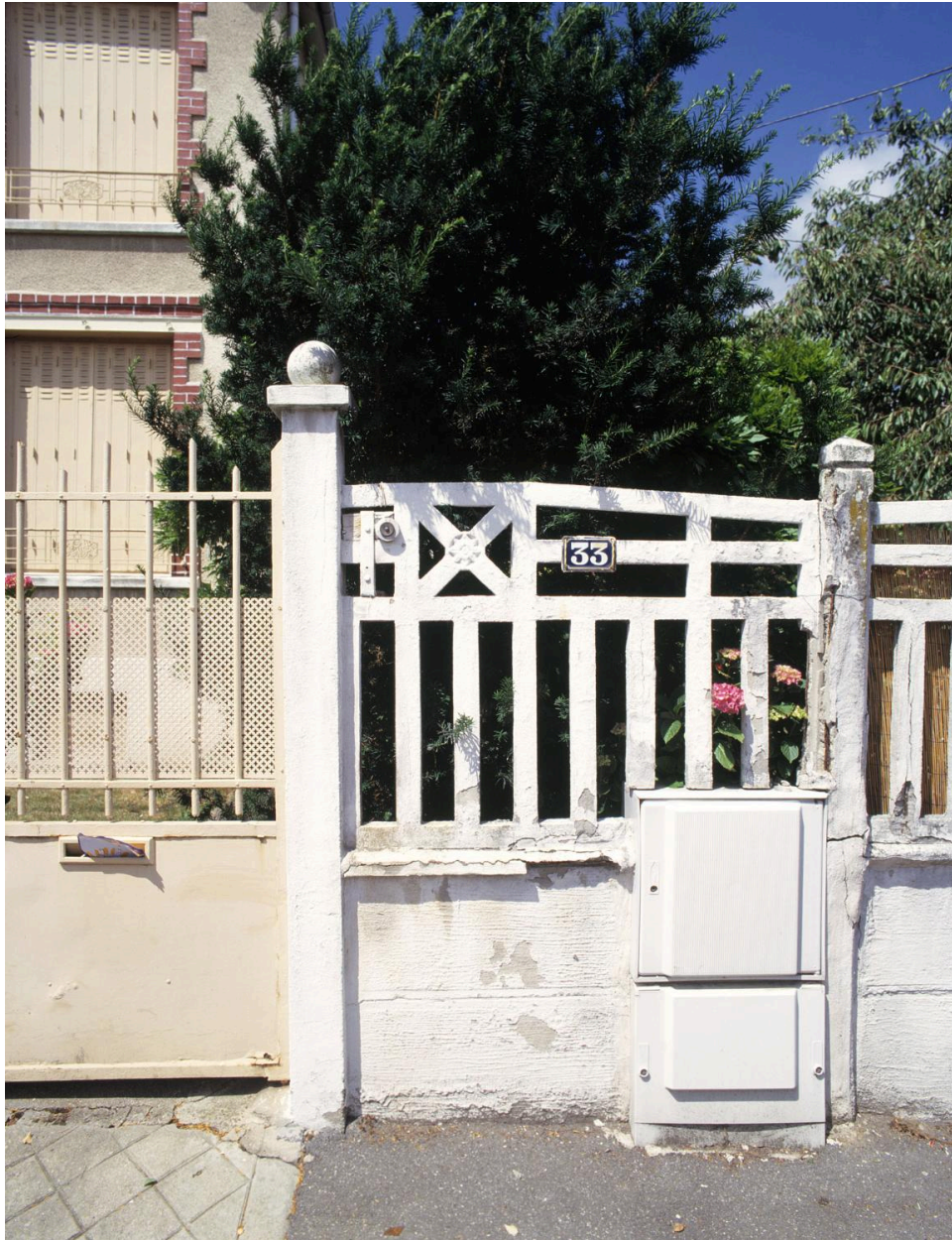
Clôture en ciment armé.
