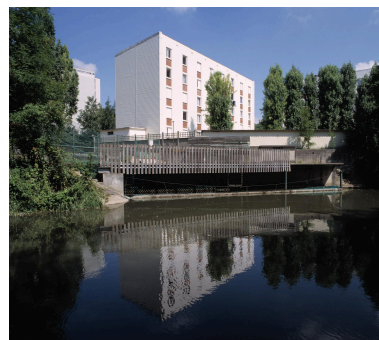
La station d'épuration des eaux pluviales des pistes d'Orly et les immeubles du Clos Perault. Phot. Philippe Ayrault IVR11_20029101069XA
