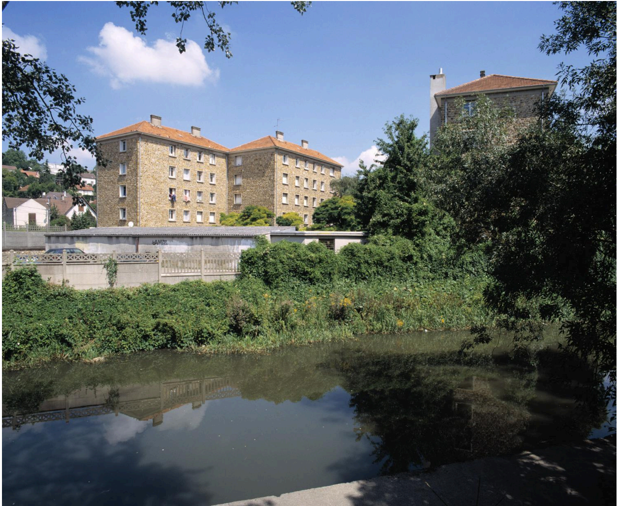
Vue des trois immeubles en meulière construits après la seconde guerre mondiale à l'emplacement de la cité provisoire de l'Orge. Au première plan : l'Orge.
