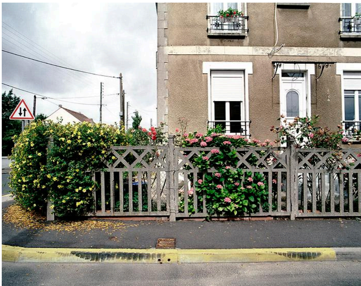
Clôture en ciment armé.
