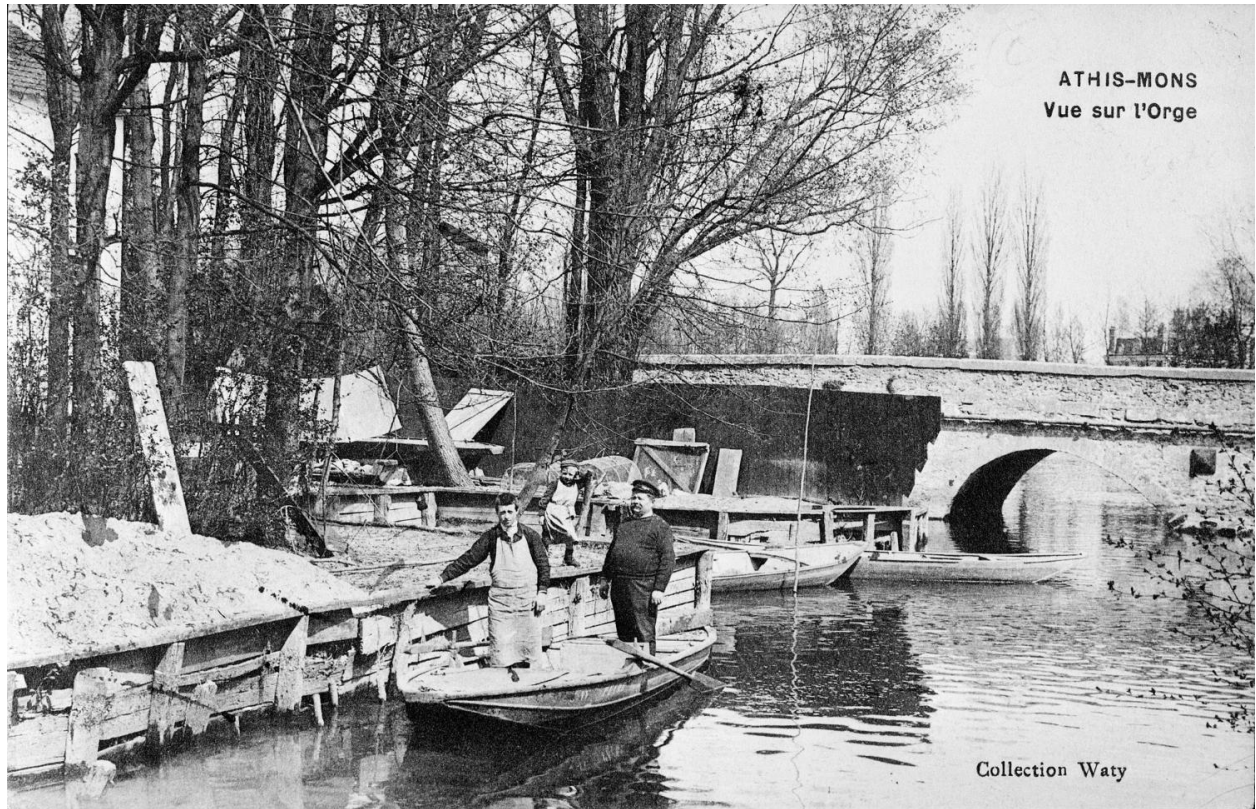
Vue du pont sur l'Orge.
