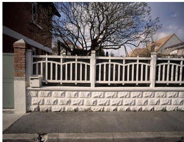
Clôture en ciment. Les panneaux ajourés reposent sur un soubassement en parpaings moulés. Phot. Philippe Ayrault IVR11_20049100010XA
