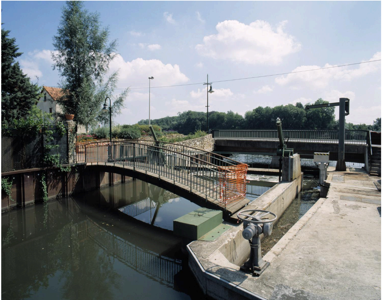
Le confluent de l'Orge et de la Seine ; au second plan, le pont en maçonnerie qui a remplacé en 1971 l'ancien pont construit en 1668.
