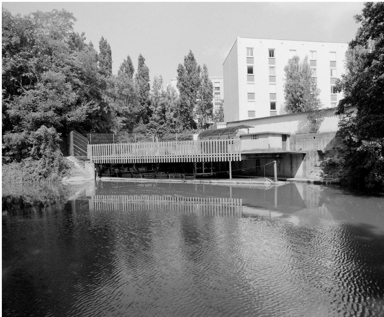
La station d'épuration des eaux pluviales des pistes d'Orly sur les bords de l'Orge.
