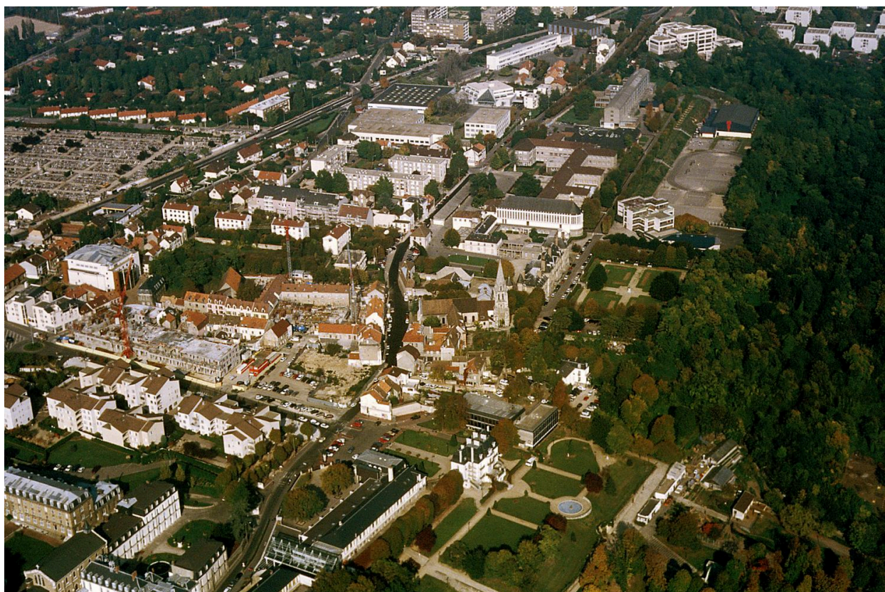
Vue aérienne : réaménagement en cours des îlots du centre-ville le long de la rue Conrart.
