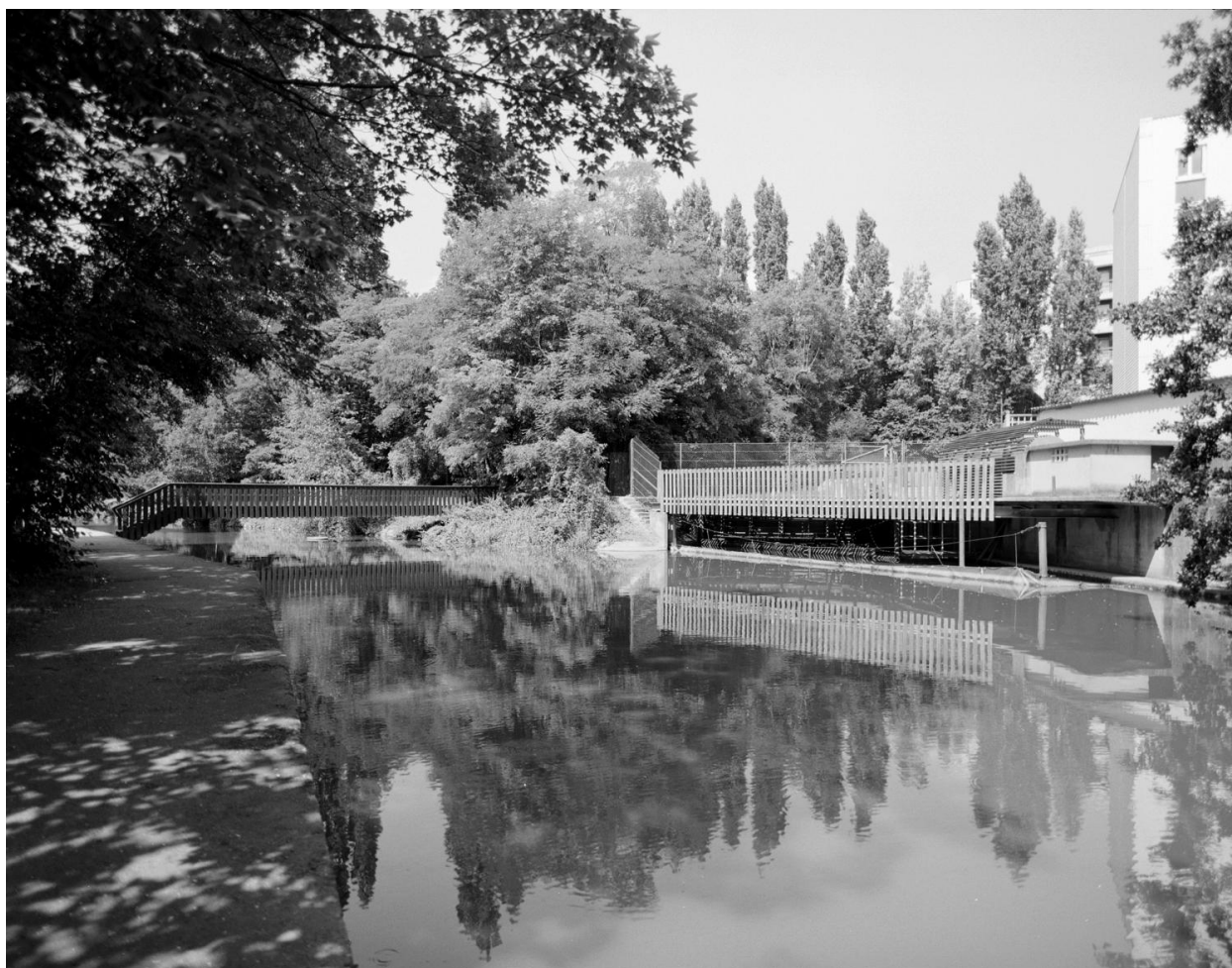
Passerelle sur l'Orge à côté de la station d'épuration des eaux pluviales des pistes d'Orly.
