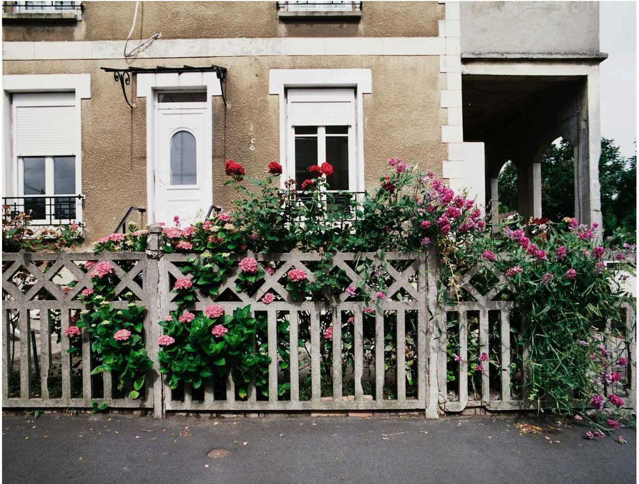
Clôture en ciment armé.
