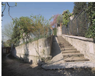
Escalier qui descend de l'avenue Constance et qui croise le sentier de la Fontaine-Garelle. Phot. Philippe Ayrault IVR11_20029100436XA
