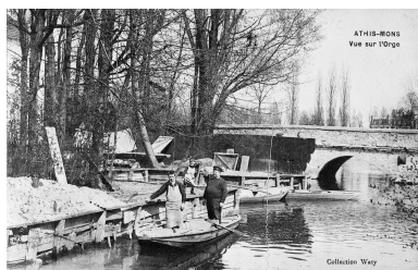
Vue du pont sur l'Orge. IVR11_20029101924NUCB
