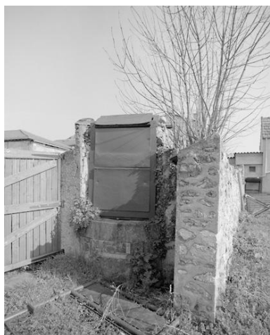
Vue du puits commun situé à l'entrée des jardins familiaux voisins de la ferme de Mons. Phot. Philippe Ayrault IVR11_20029100346X
