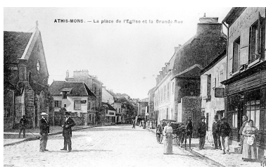
Vue d'ensemble. IVR11_20019100139XB
