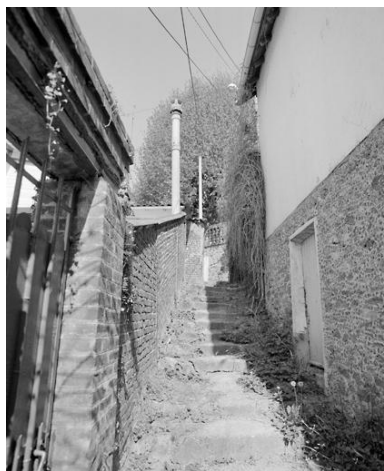
Sente débouchant sur la Villa du Coteau. Phot. Philippe Ayrault IVR11_20029100442X
