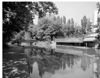
Passerelle sur l'Orge à côté de la station d'épuration des eaux pluviales des pistes d'Orly. Phot. Philippe Ayrault IVR11_20029101066X
