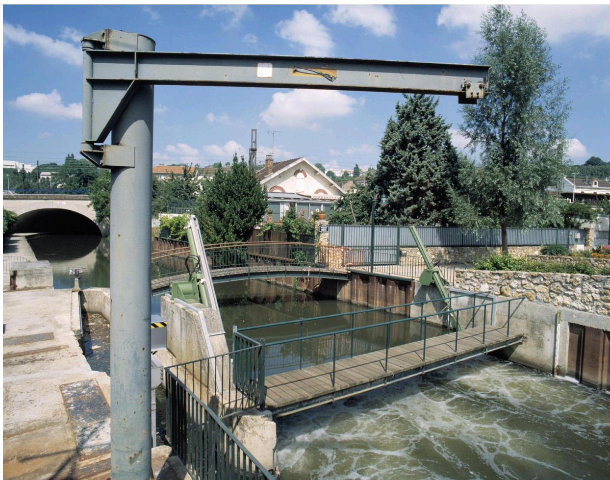
Passerelles sur l'Orge près de sa confluence avec la Seine.
