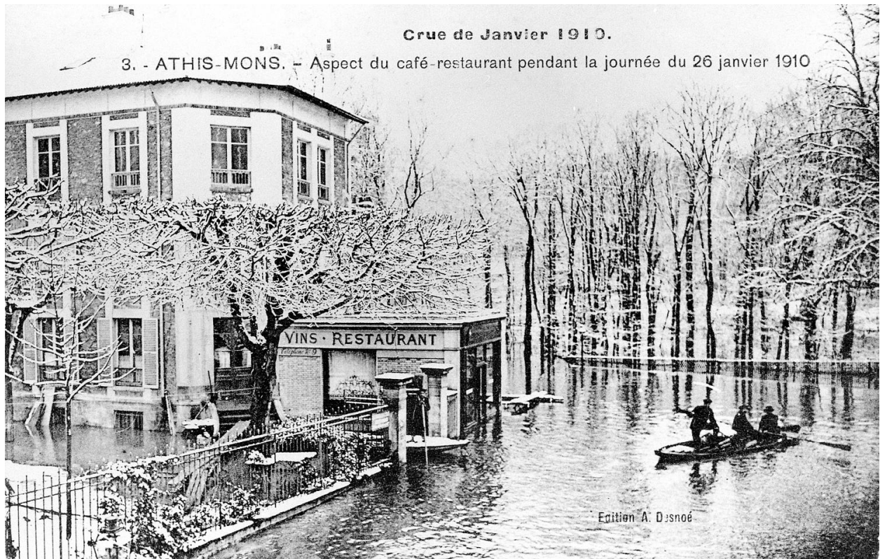
La crue de janvier 1910.
