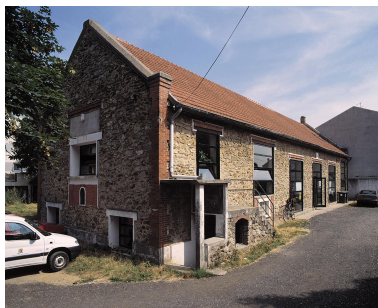
Vue de la salle paroissiale construite à côté du presbytère (anciennement logement patronal des Forges d'Athis) ; la porte d'entrée est surmontée du chronogramme 1914. Phot. Philippe Ayrault IVR11_20039101035XA
