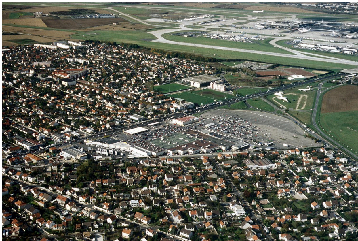
Vue aérienne de la zone pavillonnaire de part et d'autre de la RN 7 ; à gauche Paray-Vieille-Poste avec l'école Jules-Ferry et l'enclave du centre sportif Paul-Demange situé sur le territoire d'Athis-Mons ; au fond, les pistes de l'aéroport d'Orly. Cliché DDE, octobre 1994.
