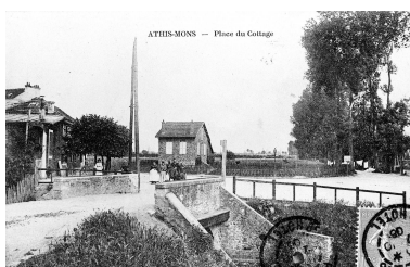
Vue d'ensemble de la place et du pont sur l'Orge. IVR11_20019100108X
