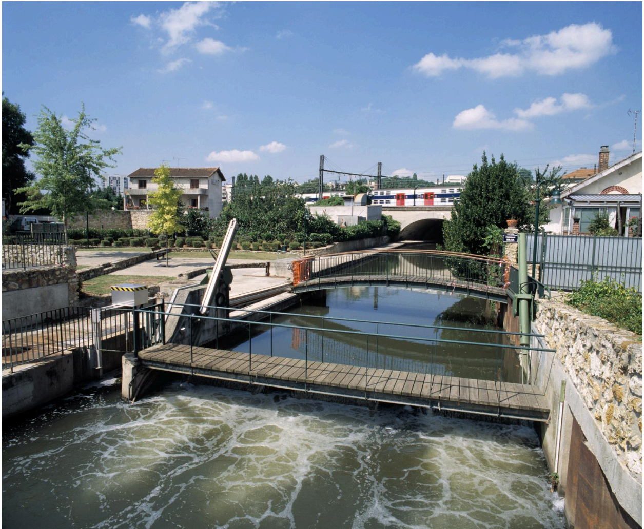
Vue perspective des passerelles surplombant l'Orge près de sa confluence avec la Seine en direction du pont de chemin de fer.
