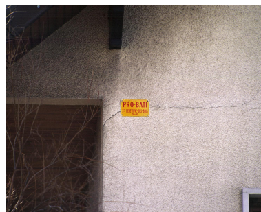
Plaque de l'entreprise de construction PRO-BATI (Sainte-Geneviève- des-Bois) apposée sur le pavillon. Phot. Philippe Ayrault IVR11_20049100001XA
