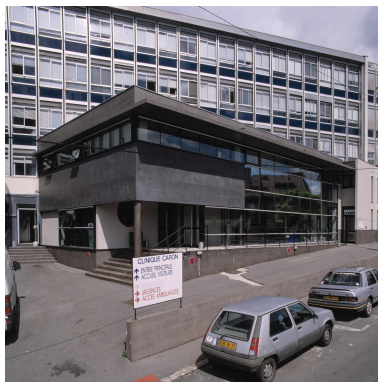
Vue de l'entrée principale. Phot. Philippe Ayrault IVR11_20029100832XA
