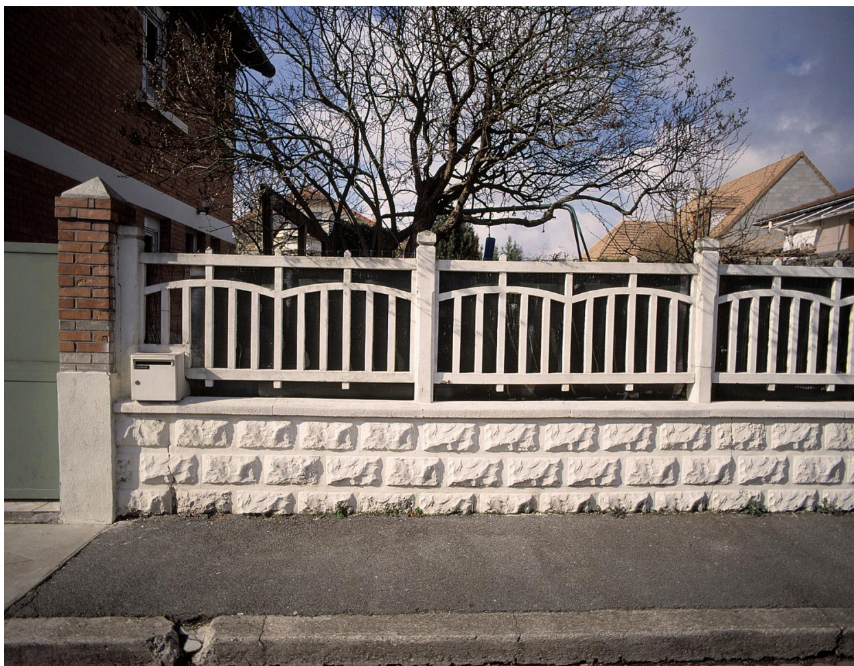
Clôture en ciment. Les panneaux ajourés reposent sur un soubassement en parpaings moulés.
