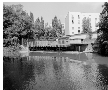
La station d'épuration des eaux pluviales des pistes d'Orly sur les bords de l'Orge. Phot. Philippe Ayrault IVR11_20029101067X
