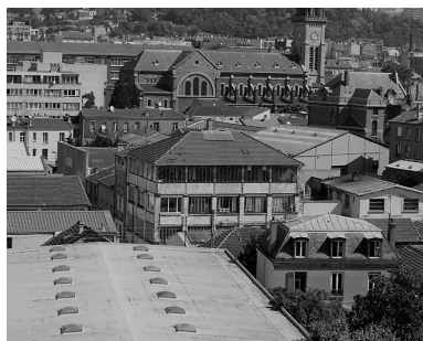
Vue générale depuis le toit de la scierie de la Société parisienne de tranchage et déroulage. Phot. Jean-Bernard Vialles IVR11_20009300191X
