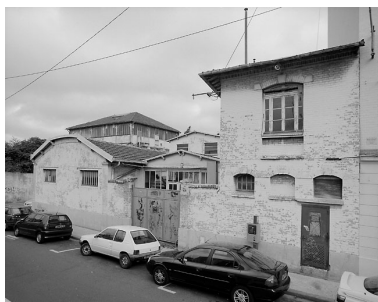
Vue générale depuis la rue du Progrès. Phot. Jean-Bernard Vialles IVR11_20019300333X
