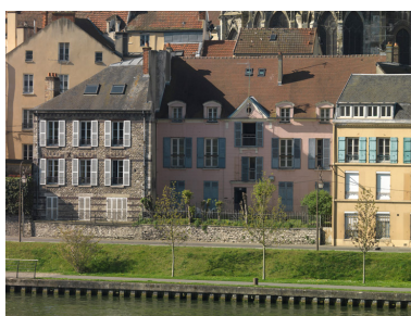
La façade sur Seine de l'hôtel qui a été récemment restauré. Phot. Laurent Kruszyk IVR11_20157800199NUC4A
