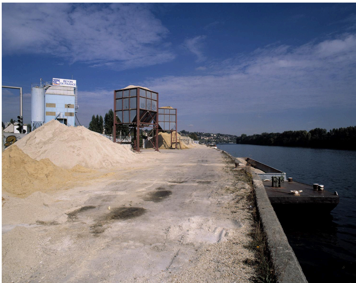
Le quai de déchargement des Entrepôts d'Athis-Mons, à côté du pont du chemin de fer PLM.
