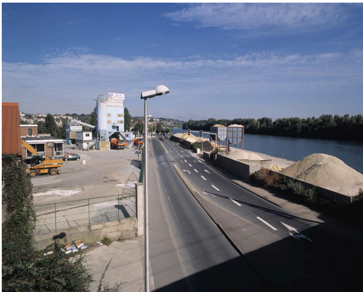
Vue d'ensemble du site à partir du pont du chemin de fer.
