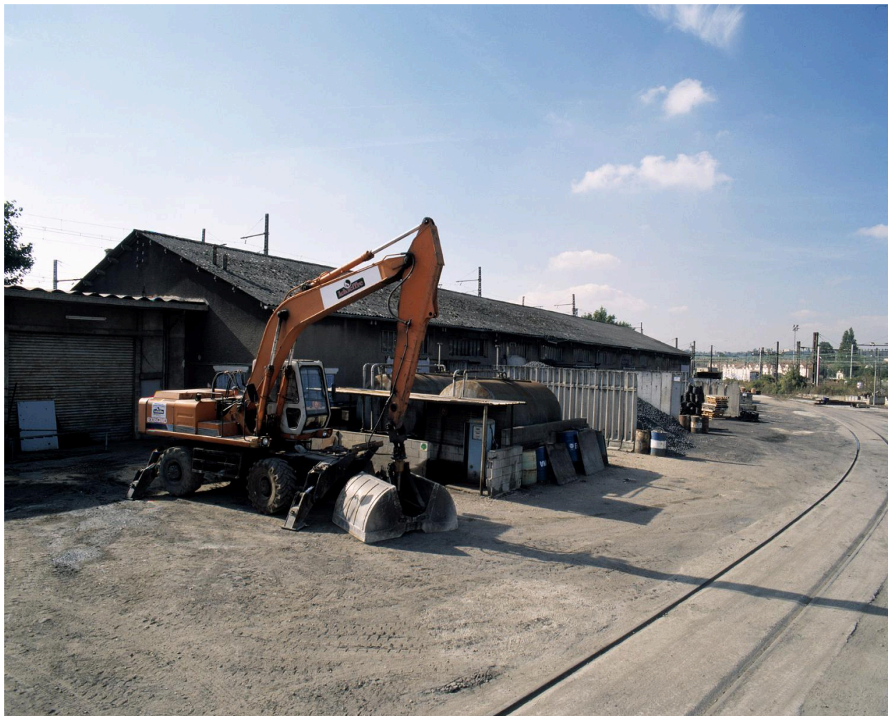
Hangar et matériel des Entrepôts ; à droite, la ligne de raccordement à la voie ferrée.
