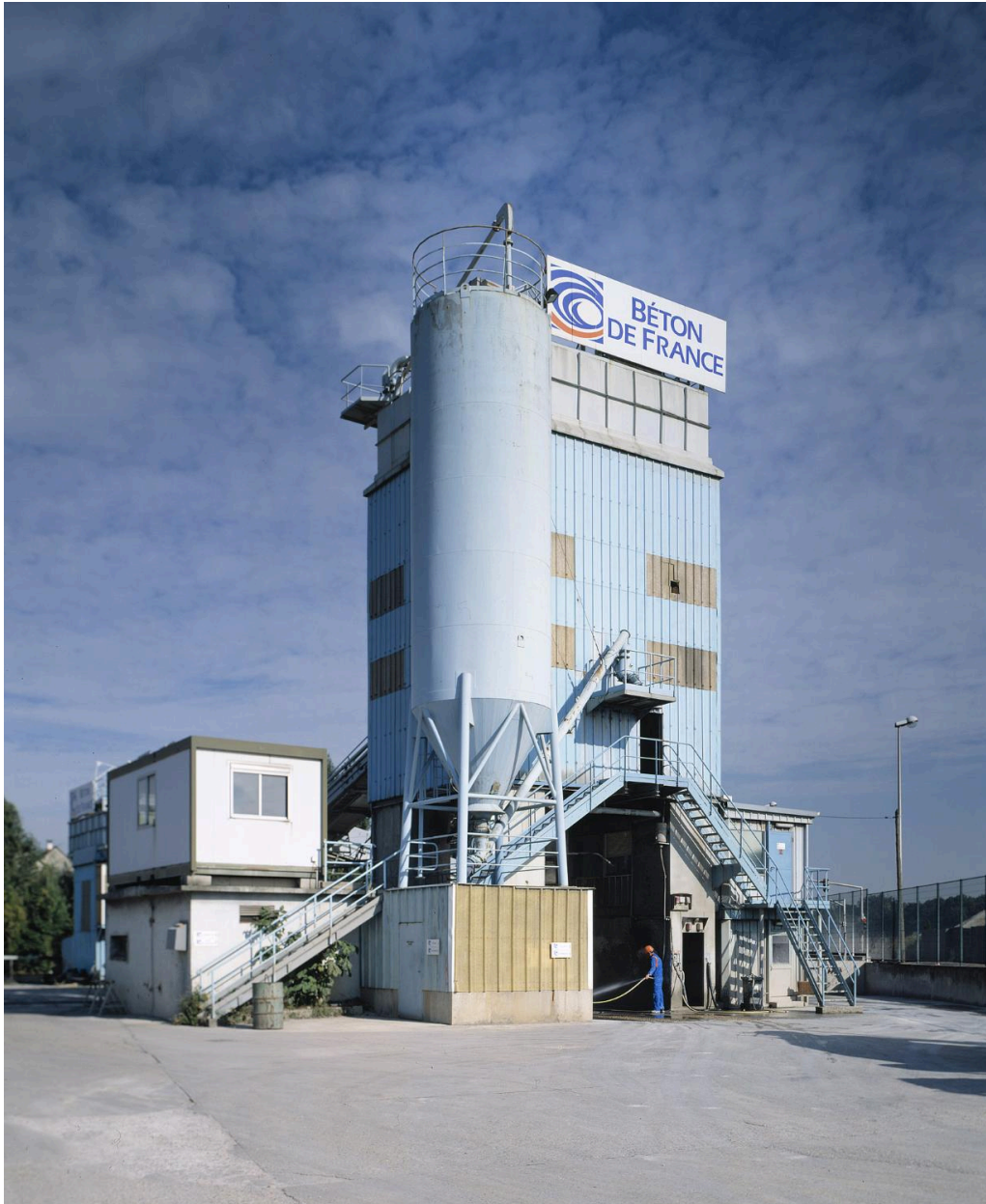
Silo de l'entreprise Béton de France, installée sur le site des Entrpôts.
