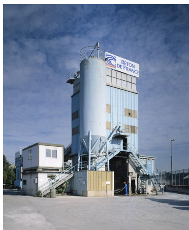
Silo de l'entreprise Béton de France, installée sur le site des Entrpôts. Phot. Philippe Ayrault IVR11_20029101463VA
