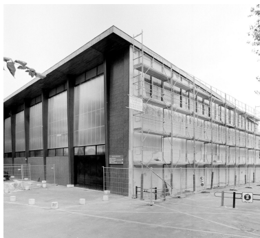
Vue du pignon sud en cours de doublement, au détriment de la mosaïque placée sur le pignon Phot. Philippe Ayrault IVR11_20029101330X
