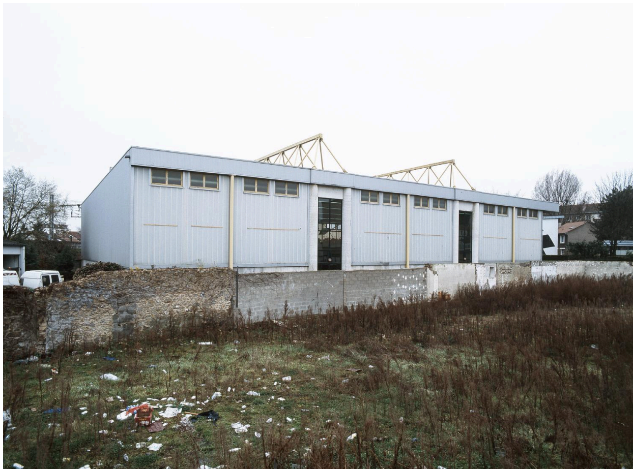
Vue générale de la façade prise du côté nord.
