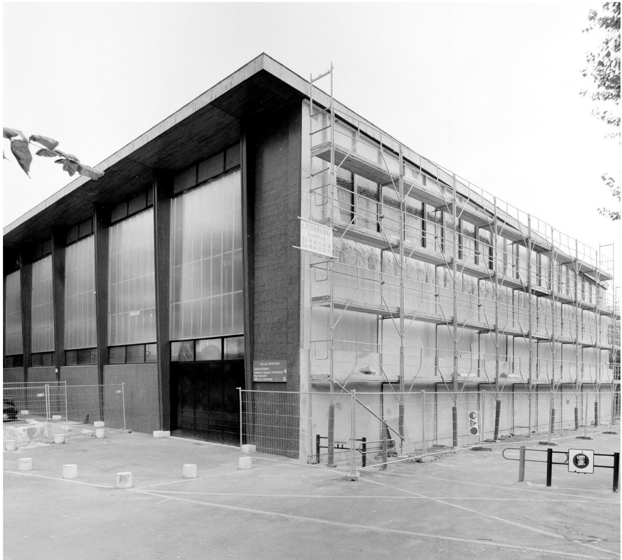
Vue du pignon sud en cours de doublement, au détriment de la mosaïque placée sur le pignon
