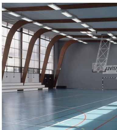
Vue des structures intérieures de bois lamellé-collé du gymnase. Phot. Philippe Ayrault IVR11_20059100577XA
