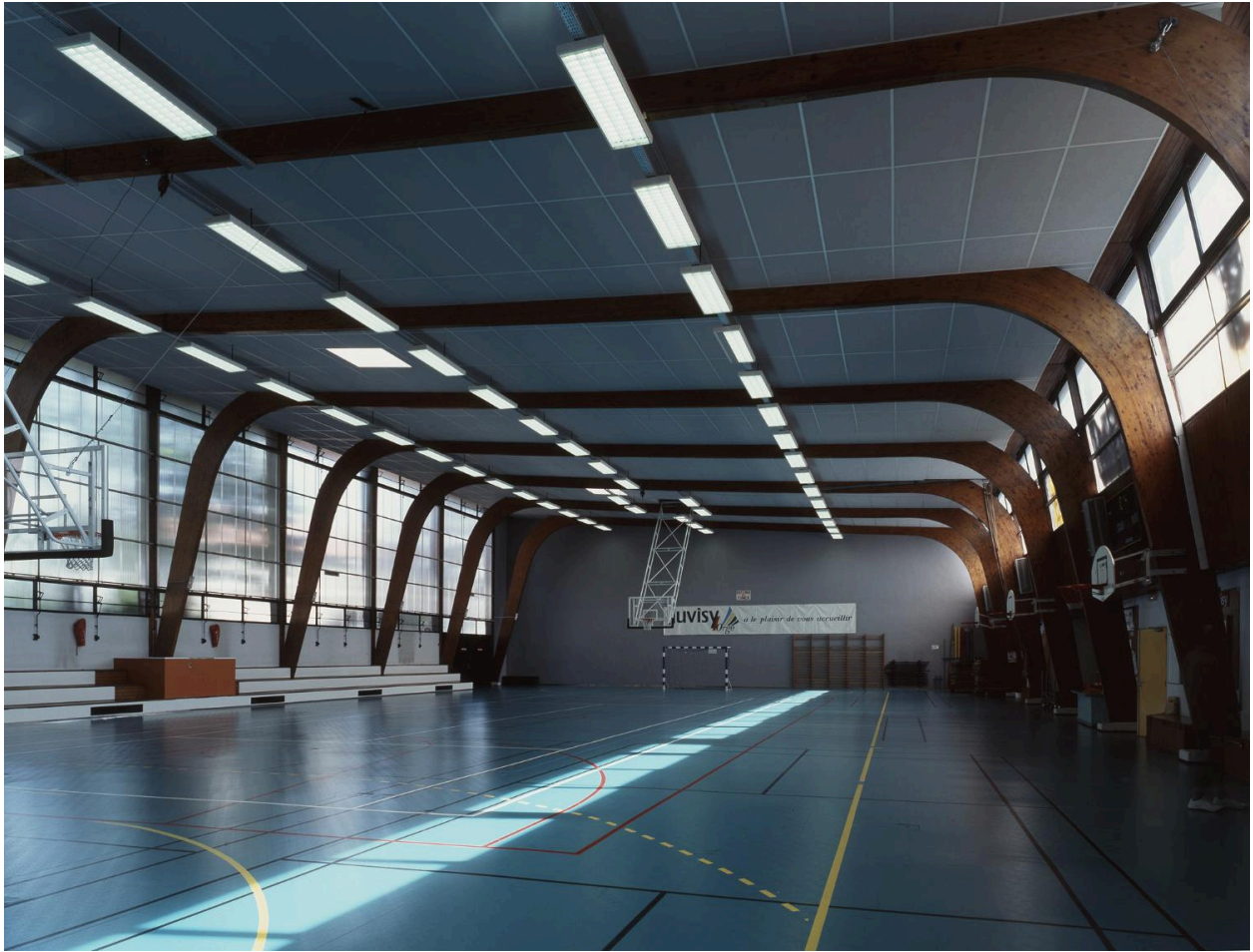
Vue d'ensemble de l'espace intérieur du gymnase
