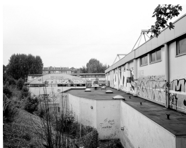
Vue du flanc est du gymnase P. Puchet et du flanc sud du gymnase Jules Ladoumègue Phot. Philippe Ayrault IVR11_20029101334X
