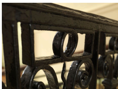
Détail de l'abaque du balustre de fer. Phot. Laurent Kruszyk IVR11_20107500386NUC4A
