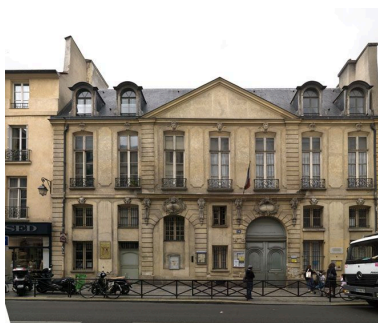
Le fronton et les consoles rocaillées datent du remaniement de la façade vers 1742. Phot. Laurent Kruszyk IVR11_20107500380NUC4A
