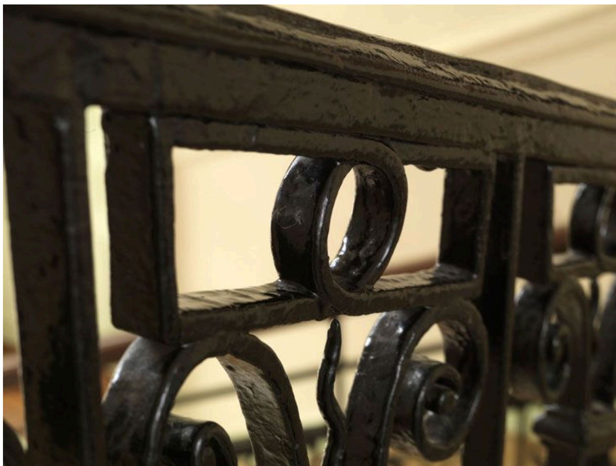
Détail de l'abaque du balustre de fer.
