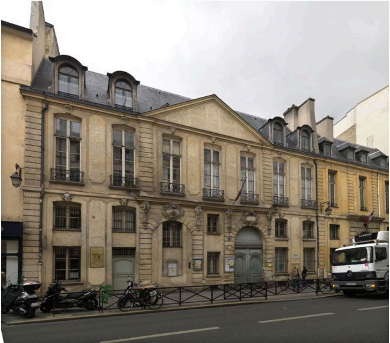
La façade principale.
