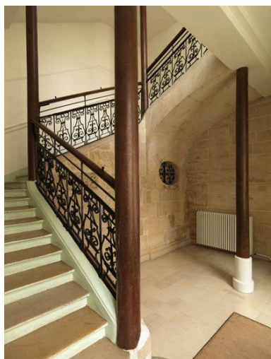
Vue du départ de l'escalier principal. Phot. Laurent Kruszyk IVR11_20107500382NUC4A
