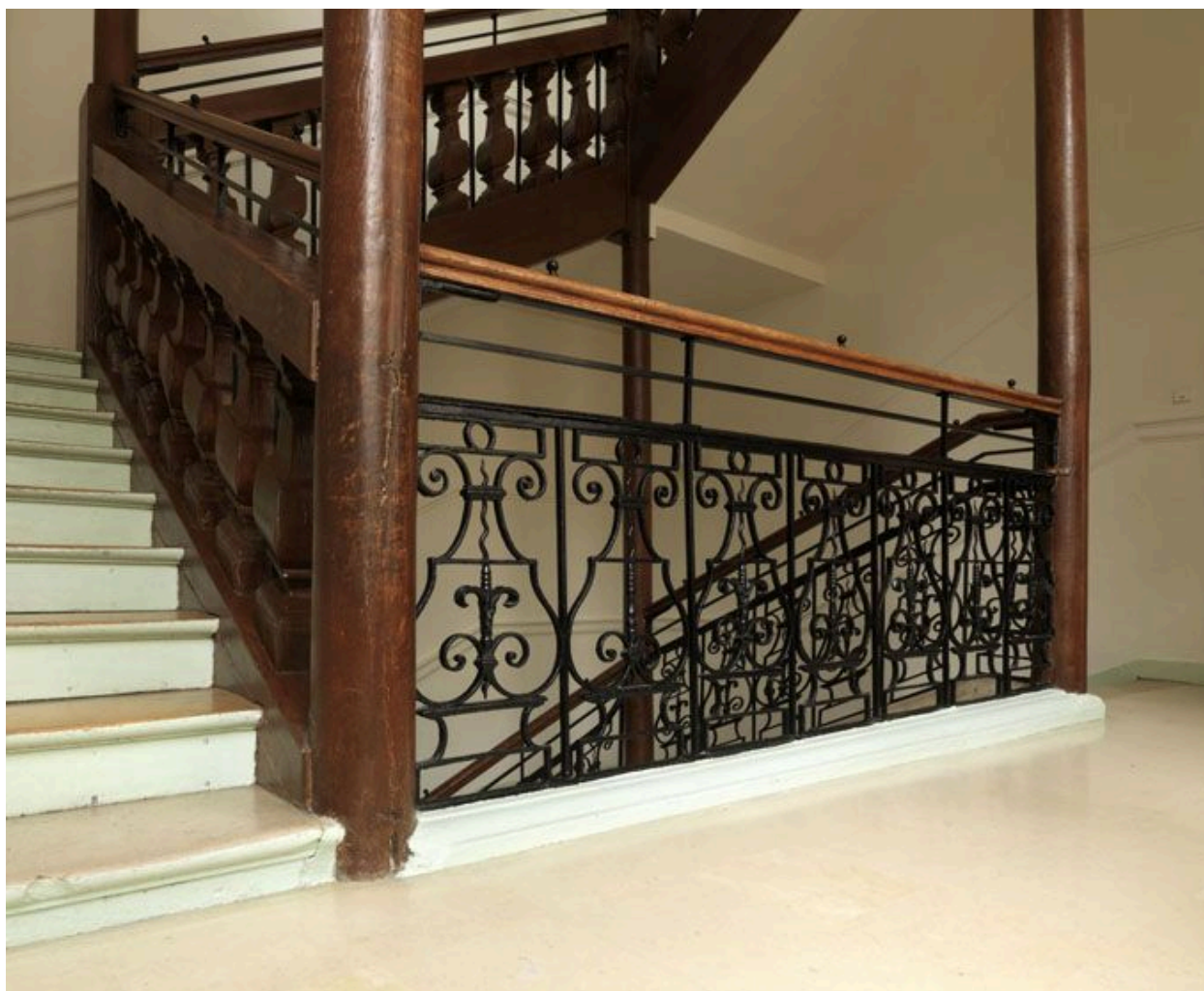
Rampe à balustres de bois et rampe à balustres de fer.
