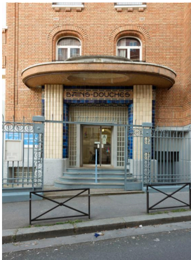
Détail de l'entrée des bains-douches, surmontée d'une coupole en pavés de verre.
