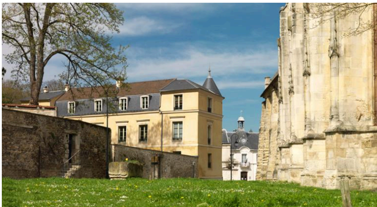
Façade postérieure, vue depuis le chevet de l'église.
