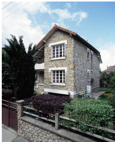
Vue d'ensemble. Phot. Philippe Ayrault IVR11_20049100468XA
