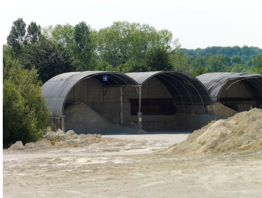
Hangars d'entreposage des produits. Phot. Philippe Ayrault IVR11_20127700678NUC4A
