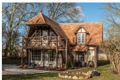
maison d'été Phot. Stéphane Asseline IVR11_20207700029NUC4A
