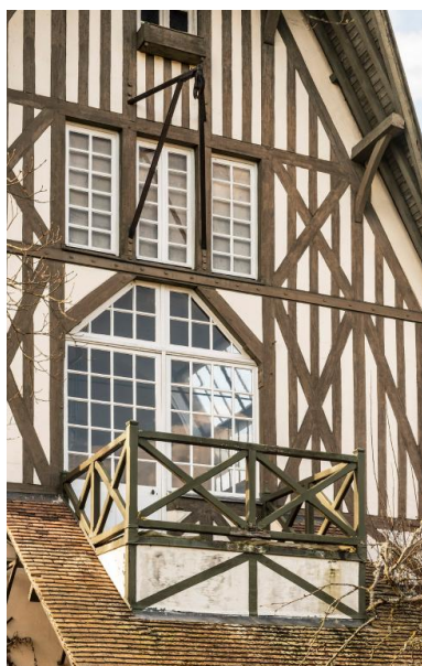
Détail de la verrière Phot. Stéphane Asseline IVR11_20207700026NUC4A
