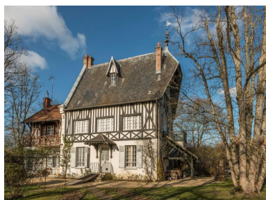
Vue générale Phot. Stéphane Asseline IVR11_20207700023NUC4A
