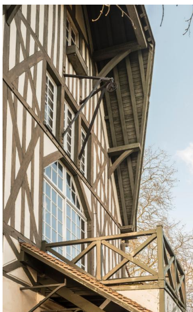
Détail de la verrière (2) Phot. Stéphane Asseline IVR11_20207700027NUC4A
