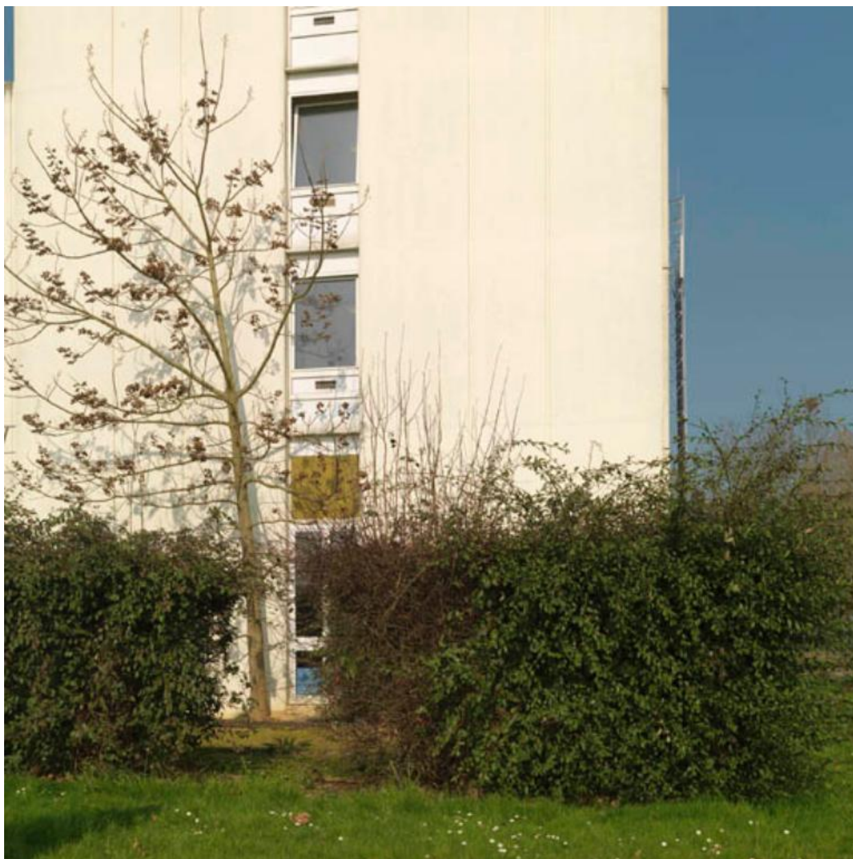
Vue latérale de l'un des immeubles du foyer.
