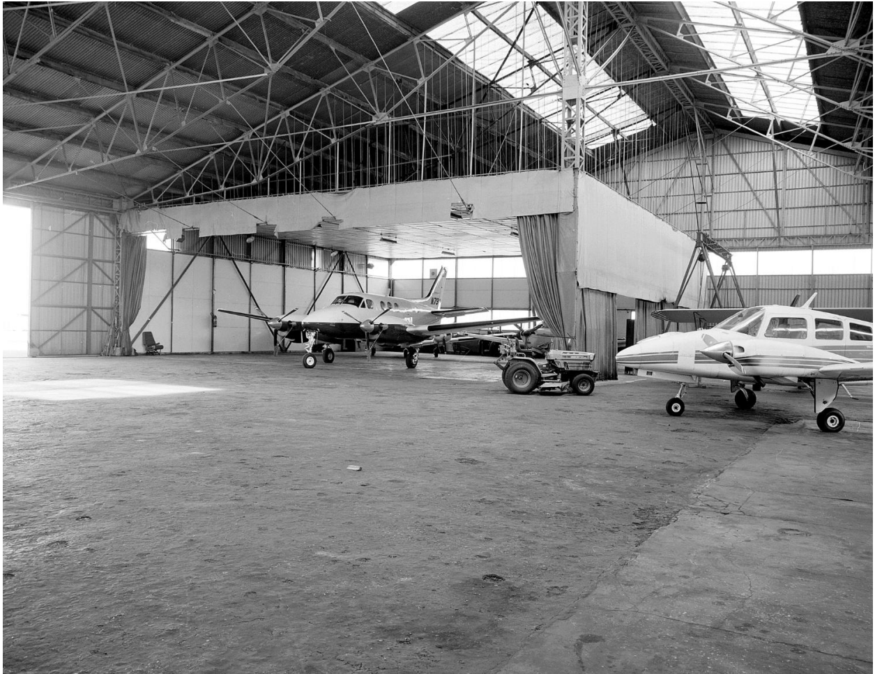
Vue d'ensemble de l'atelier de réparations.
