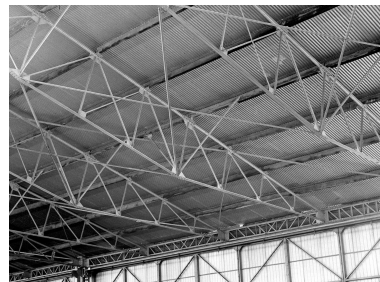
Détail des fermes métalliques. Phot. Christian Décamps IVR11_20007800306X
