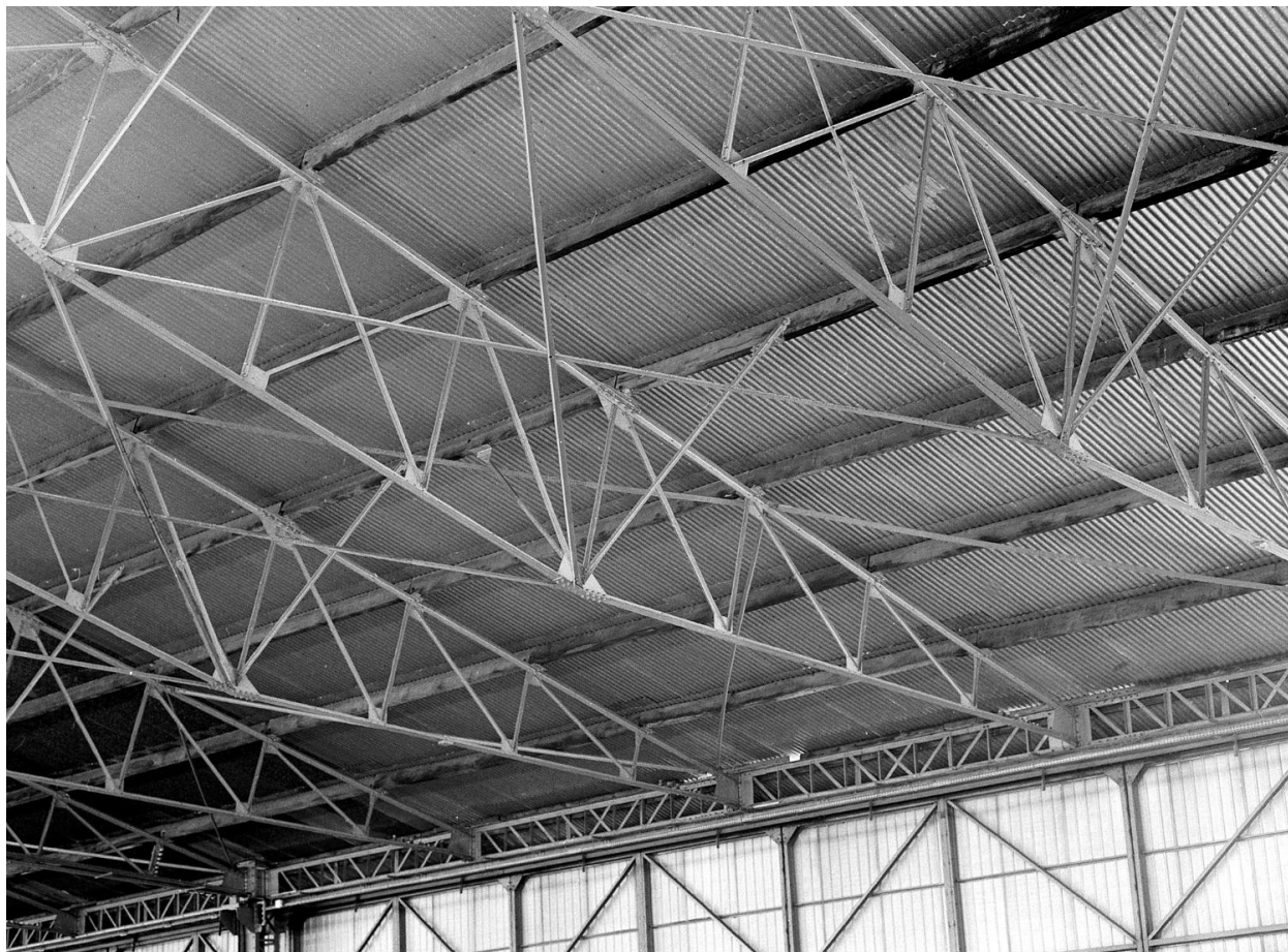
Détail des fermes métalliques.
