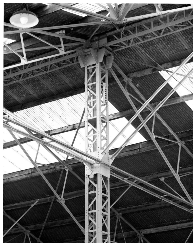
Détail de la charpente métallique.
