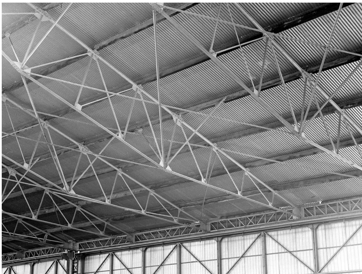
Détail des fermes métalliques.
