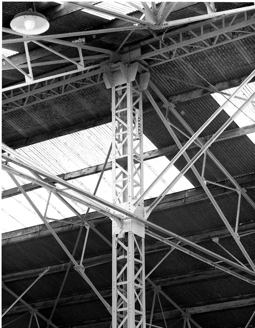
Détail de la charpente métallique.
