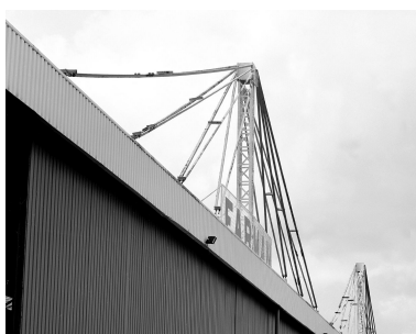
Détail des haubans. Phot. Christian Décamps IVR11_20007800309X
