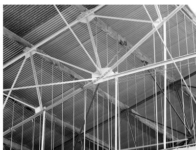
Détail des fermes métalliques de l'atelier de réparations. Phot. Christian Décamps IVR11_20007800307X
