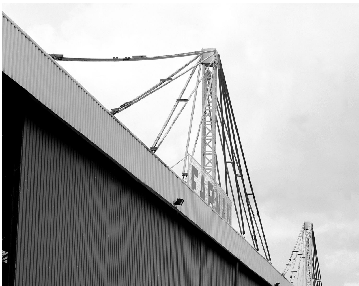
Détail des haubans.
