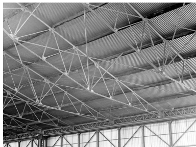
Détail des fermes métalliques. Phot. Christian Décamps IVR11_20007800305X
