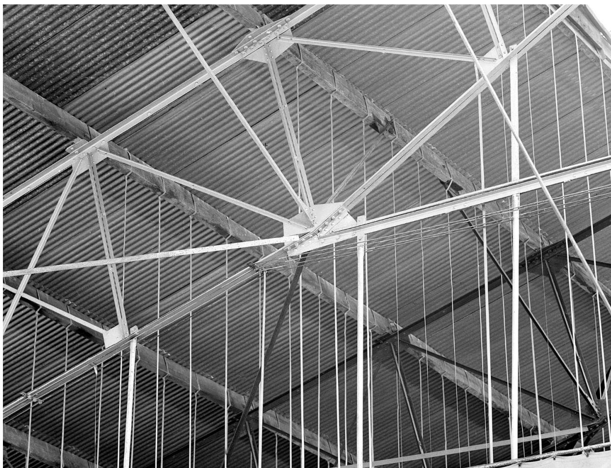
Détail des fermes métalliques de l'atelier de réparations.
