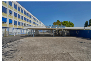
L'entrée du lycée et à gauche, la longue barre de l'externat réservé aux garçons. Phot. Philippe Ayrault IVR11_20209300520NUC4A
