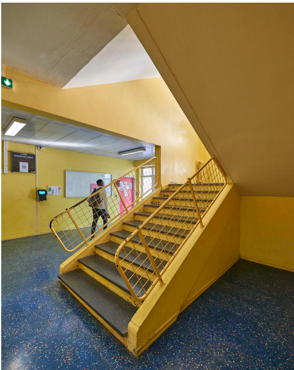
Détail des circulations conduisant aux salles de classes.
