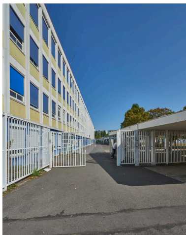
L'entrée du lycée et le bâtiment de l'externat des garçons. On y reconnaît la stricte application de la trame d'1,75 m mise au point en 1952 par le ministère de l'Education nationale. Phot. Philippe Ayrault IVR11_20209300524NUC4A
