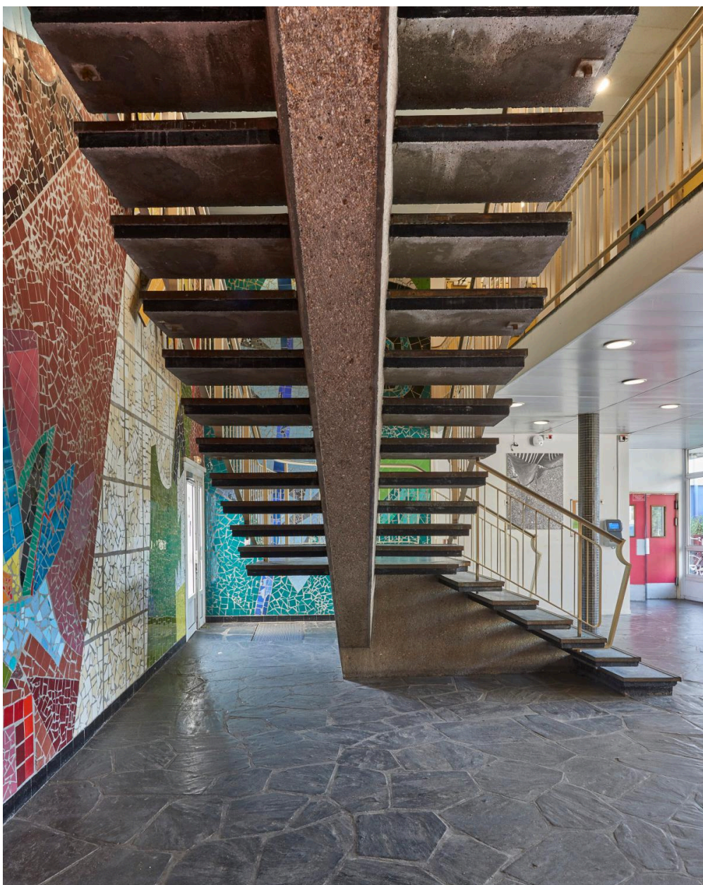
Détail de la pile de l'escalier conduisant aux bureaux de l'administration.
