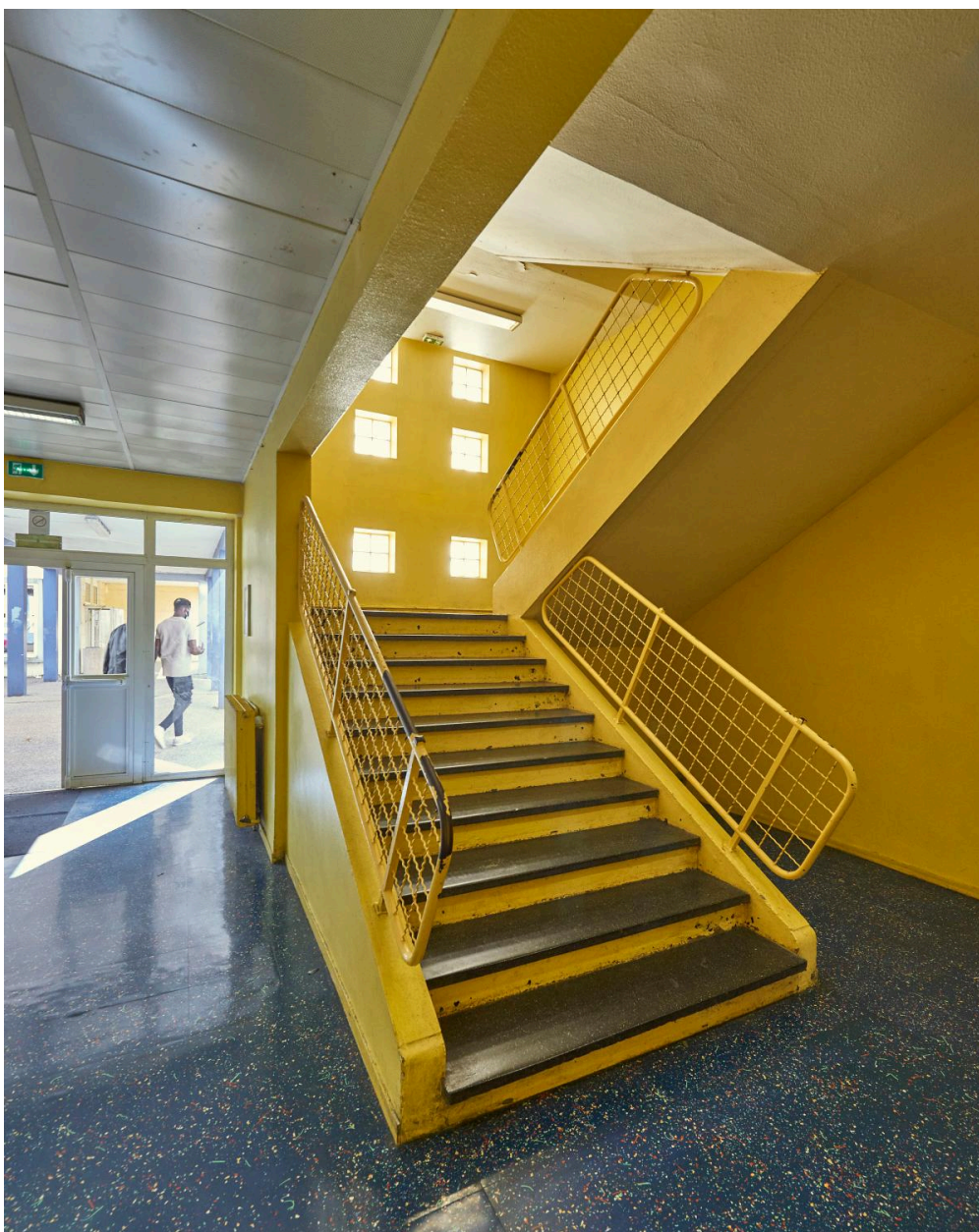
Détail d'une circulation verticale. Les escaliers sont éclairés par des claustras de béton moulé.
