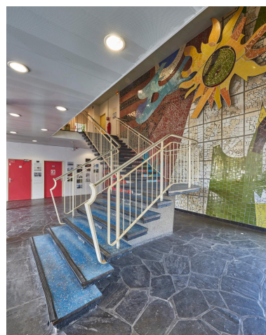
La fonction de prestige du hall de l'administration est mise en valeur par un sol en dalles irrégulières d'ardoise brute et par un bel escalier suspendu supporté par une unique pile en béton gravillonné d'une grande finesse d'exécution. Phot. Philippe Ayrault IVR11_20209300506NUC4A
