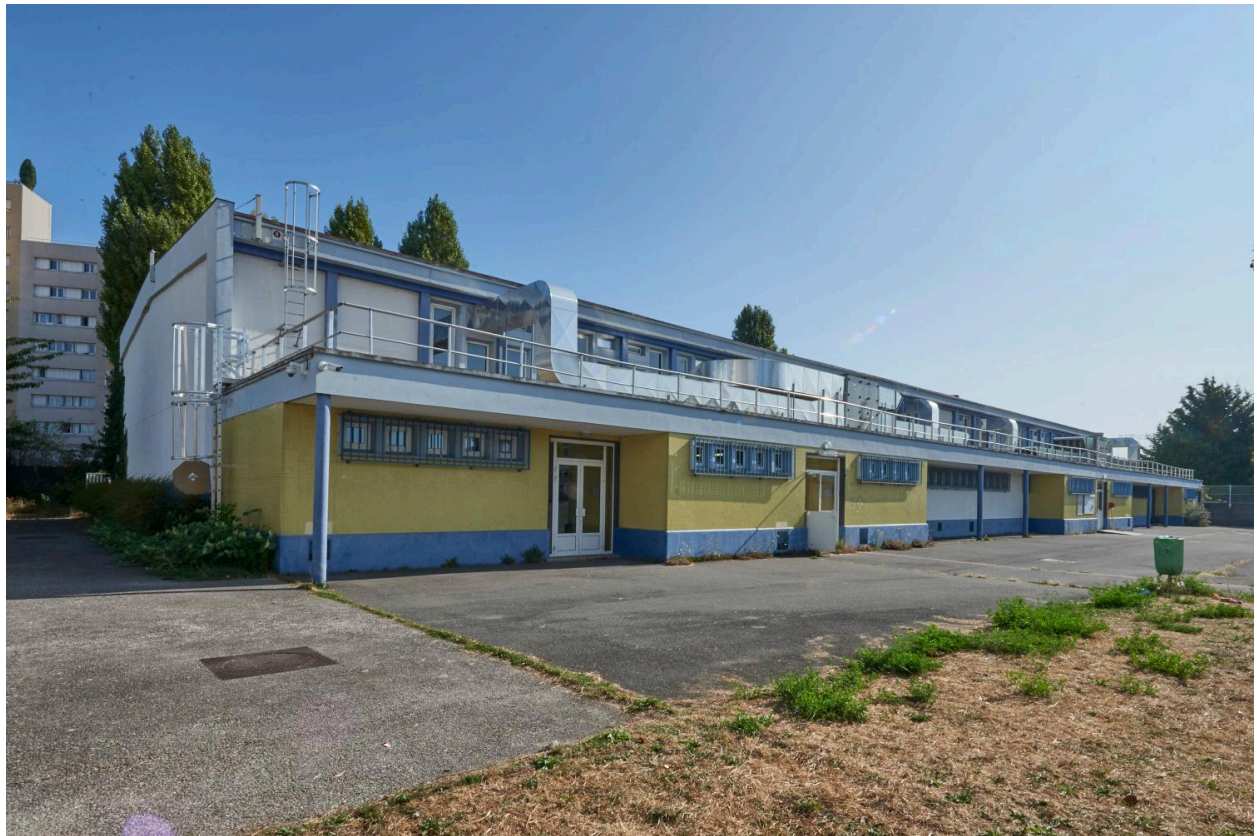
Le gymnase, situé au nord-est de la vaste parcelle du lycée. Il est achevé en 1967.
