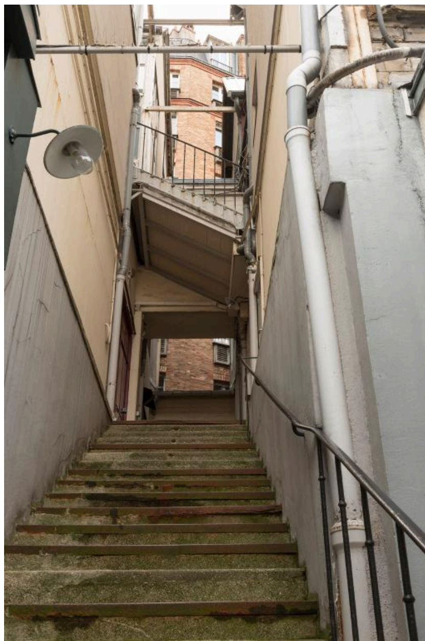
Accès aux ateliers construits dans l'entre-deux-guerres
