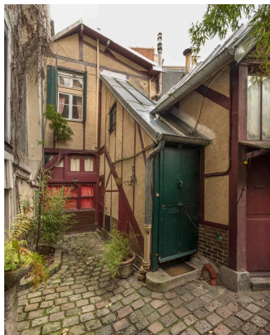
Vue d'un des ateliers et de sa cour partagée Phot. Laurent Kruszyk IVR11_20197500054NUC4A
