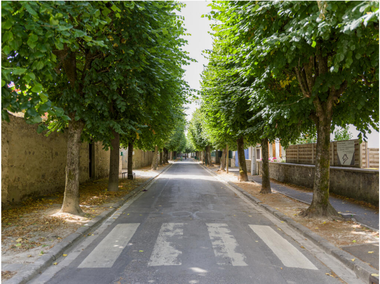
Vue générale du boulevard Sadi Carnot depuis l'est.
