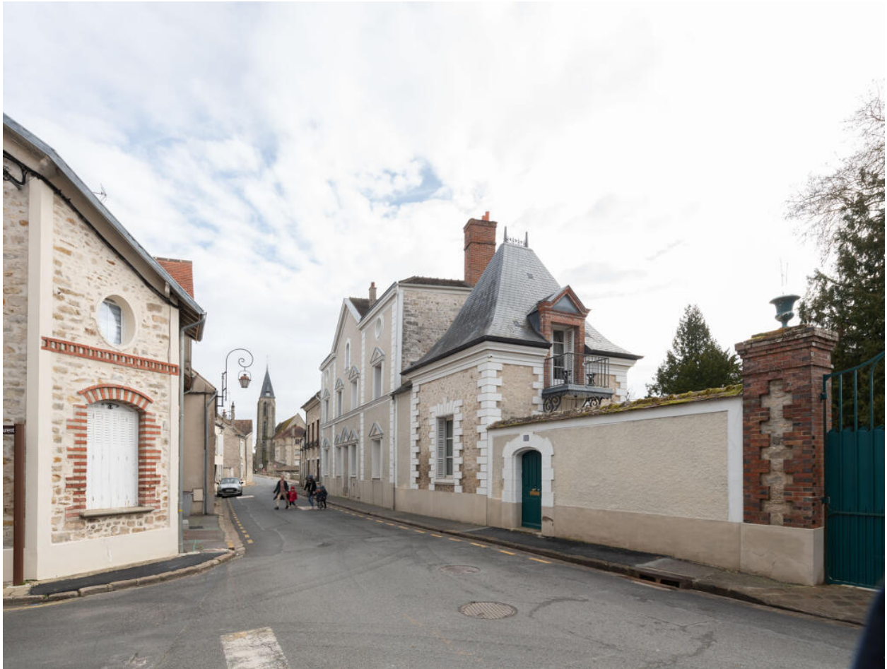
La rue Saint-Pierre au niveau de la rue Saint-Laurent, vue depuis le nord-ouest.
