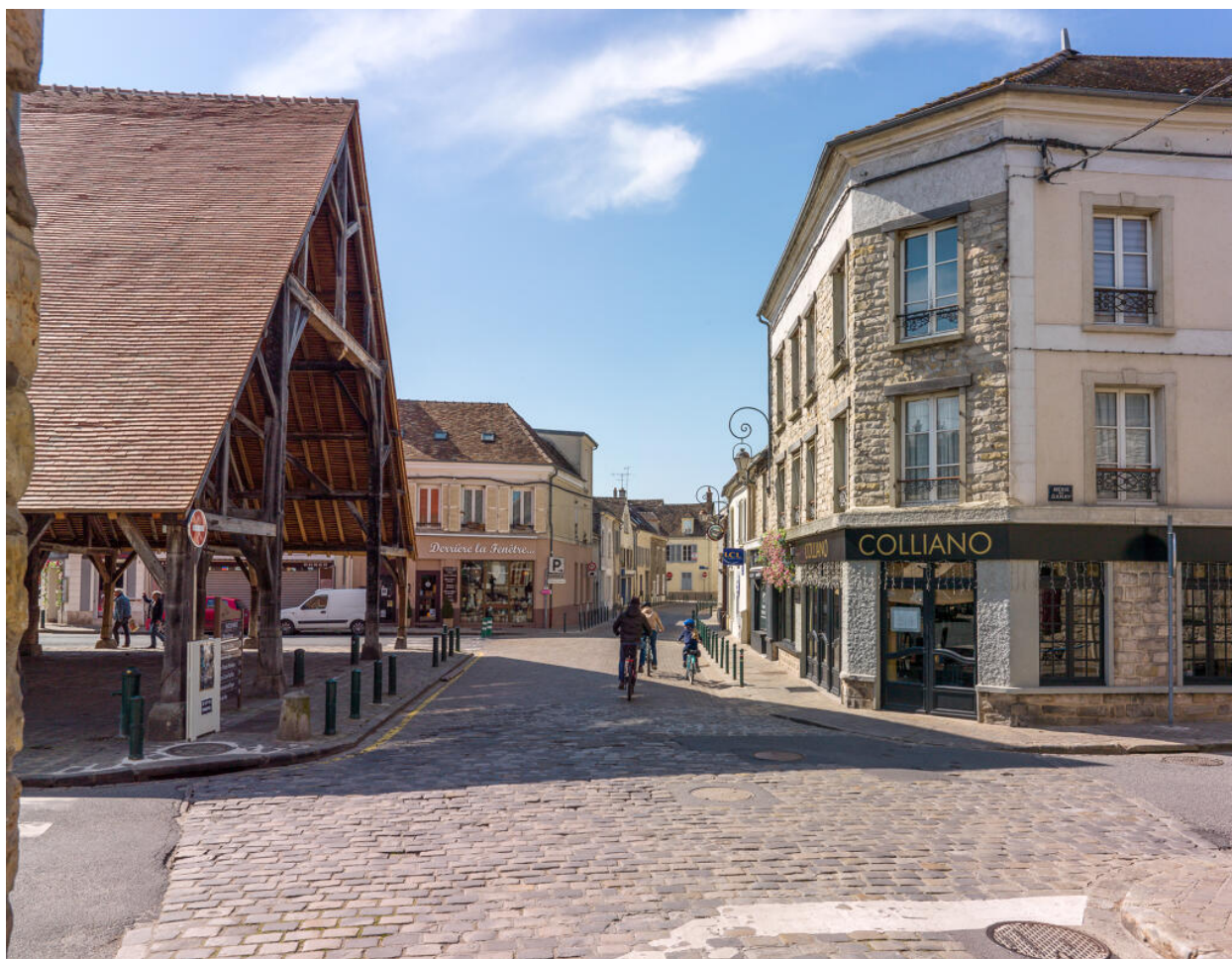
Vue de la rue Langlois, au niveau de la place du Marché, depuis l'est.
