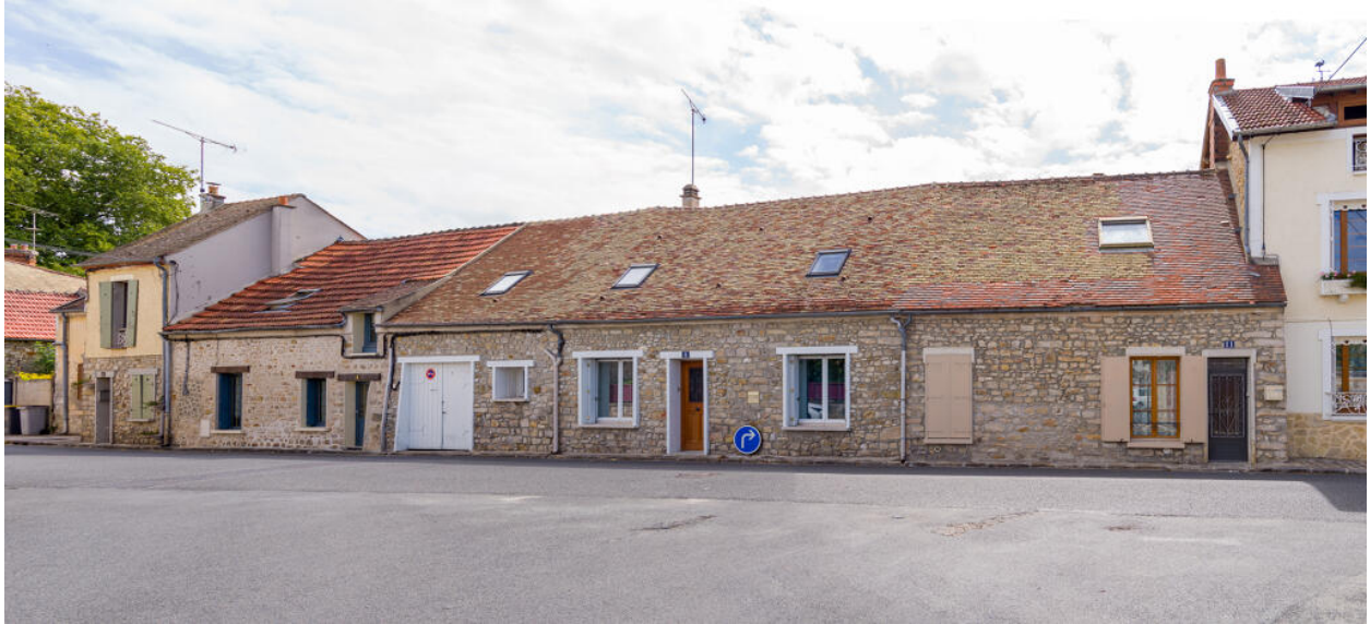
Vue générale du côté sud de la rue Pachau depuis le nord-ouest.
