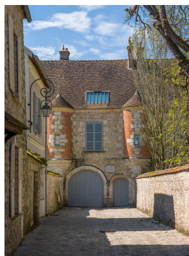
L'extrémité ouest de la rue du Lau donnant sur l'entrée de l'ancienne dépendance du château. Phot. Asseline Stéphane IVR11_20259100139NUC4A
