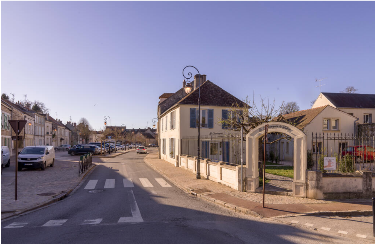
Vue générale de la place du Colombyer depuis le nord.
