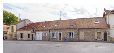
Vue générale du côté sud de la rue Pachau depuis le nord-ouest. Phot. Asseline Stéphane IVR11_20259100865NUC4A
