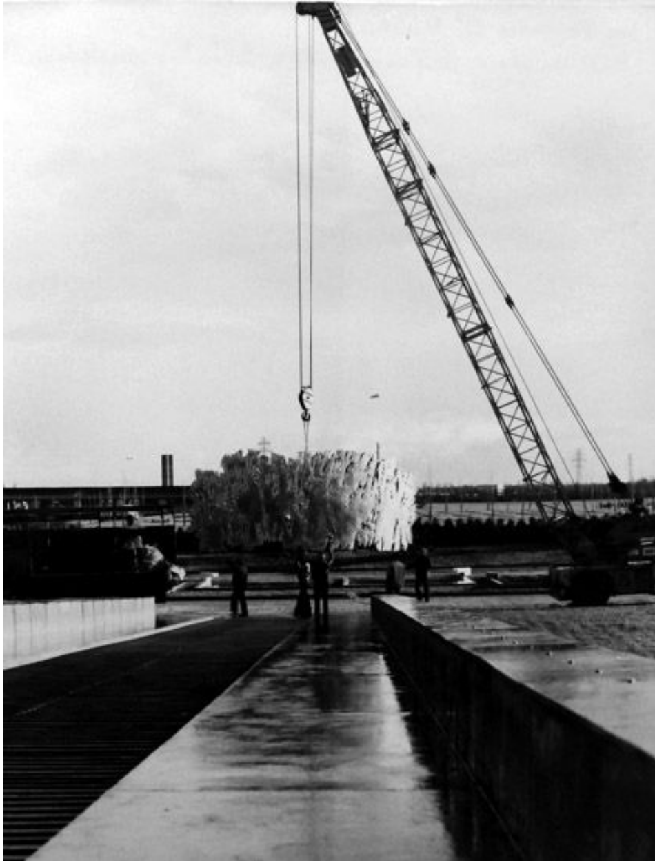
La livraison d'un des deux paravents déchargé du camion le transportant à l'aide d'une grue. Photographie NB, [1974].
