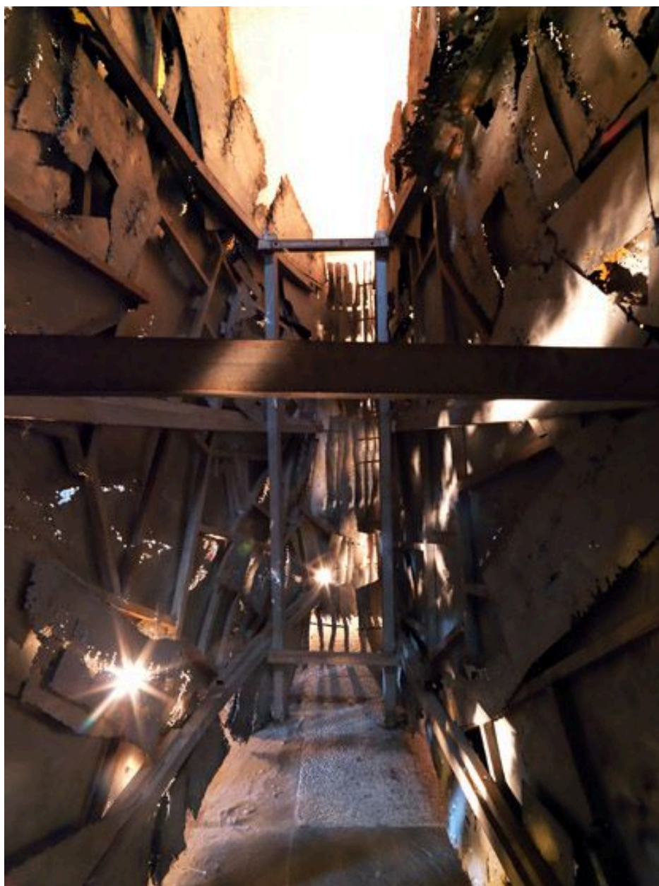
Vue intérieure du volume sculpté. On distingue la structure métallique porteuse.
