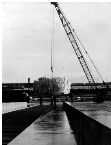
La livraison d'un des deux paravents déchargé du camion le transportant à l'aide d'une grue. Photographie NB, [1974]. Phot. Isabelle (reproduction) Duhau, Autr. Pierre (photographe) Joly, Autr. Véra (photographe) Cardot IVR11_20149400055NUCA
