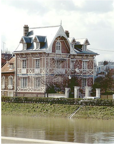
Faces antérieure et latérale. Phot. Christian Décamps IVR11_19889400143XA
