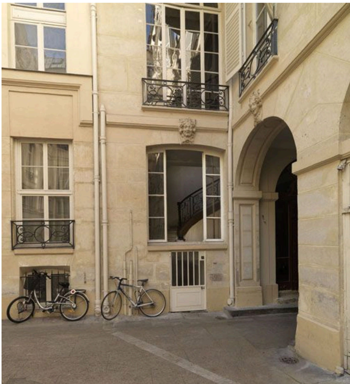
Vue de l'emplacement de l'escalier, à droite du passage cocher.
