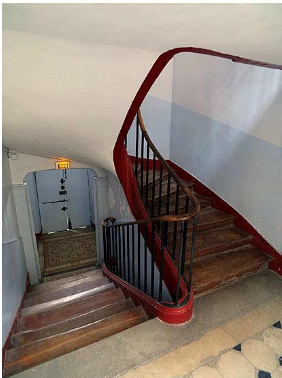
Le bâtiment du XVIIIe siècle : l'escalier sud.
