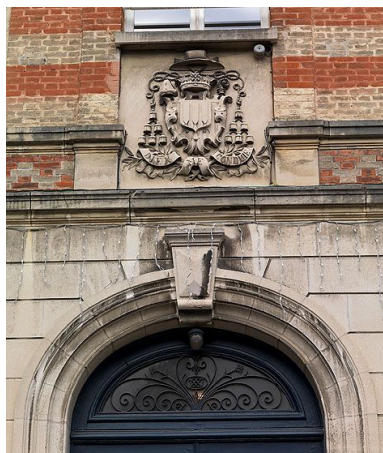
Détail de la porte centrale du corps de bâtiment principal, côté sud : la date "1887" est portée sur la ferronnerie de l'imposte. Au- dessus, armes du cardinal de Briey, évêque de Meaux de 1884 à 1909. Phot. Jean-Bernard Vialles IVR11_20127700880NUC4A
