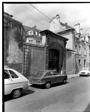
Vue d'ensemble de la façade sur rue en 1977. Phot. Pascal Corbière IVR11_19777800869X
