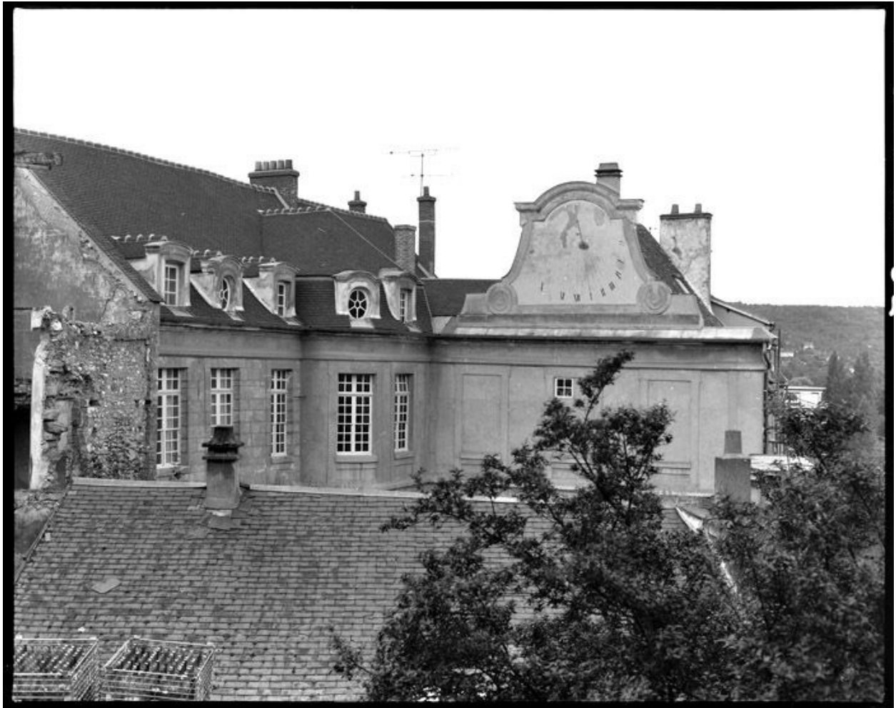
La façade sur cour en 1977.
