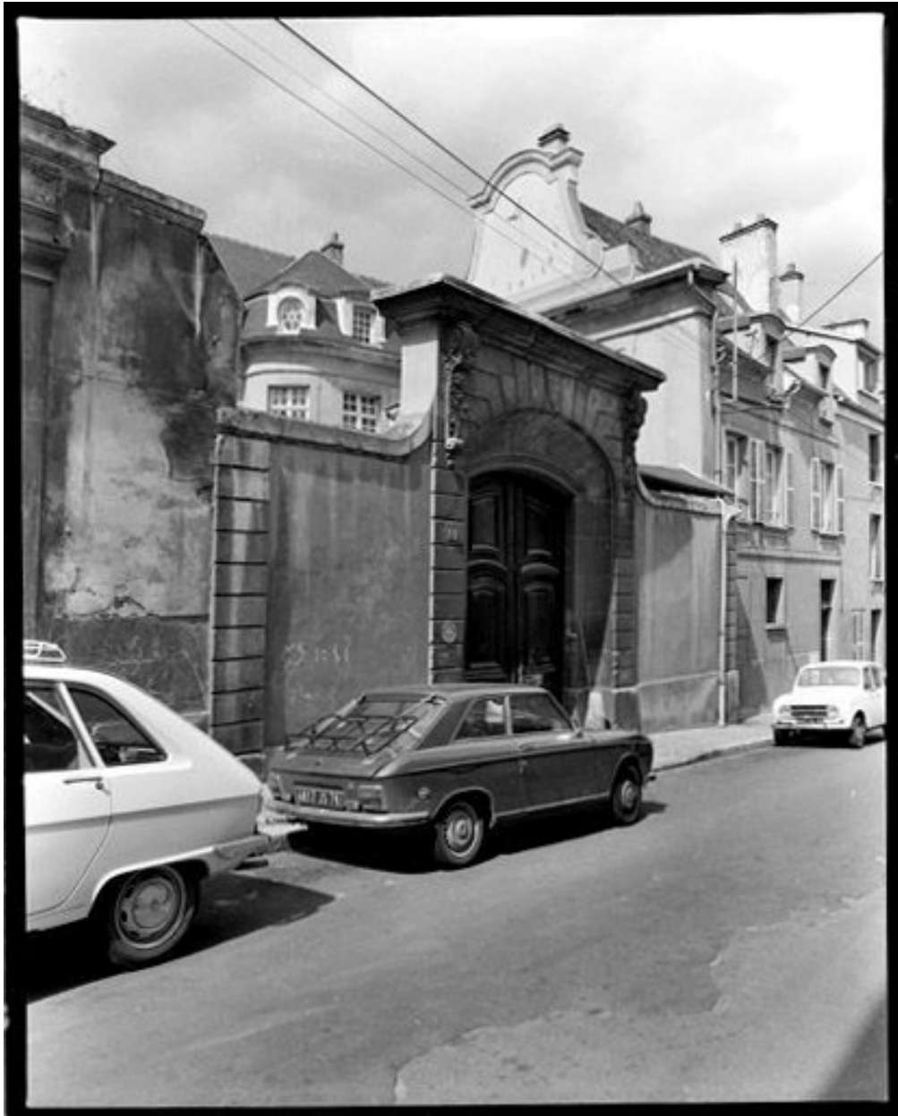
Vue d'ensemble de la façade sur rue en 1977.
