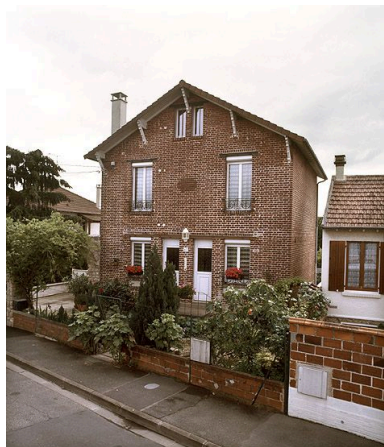
Façade principale. Phot. Laurent Kruszyk IVR11_20067800460XA
